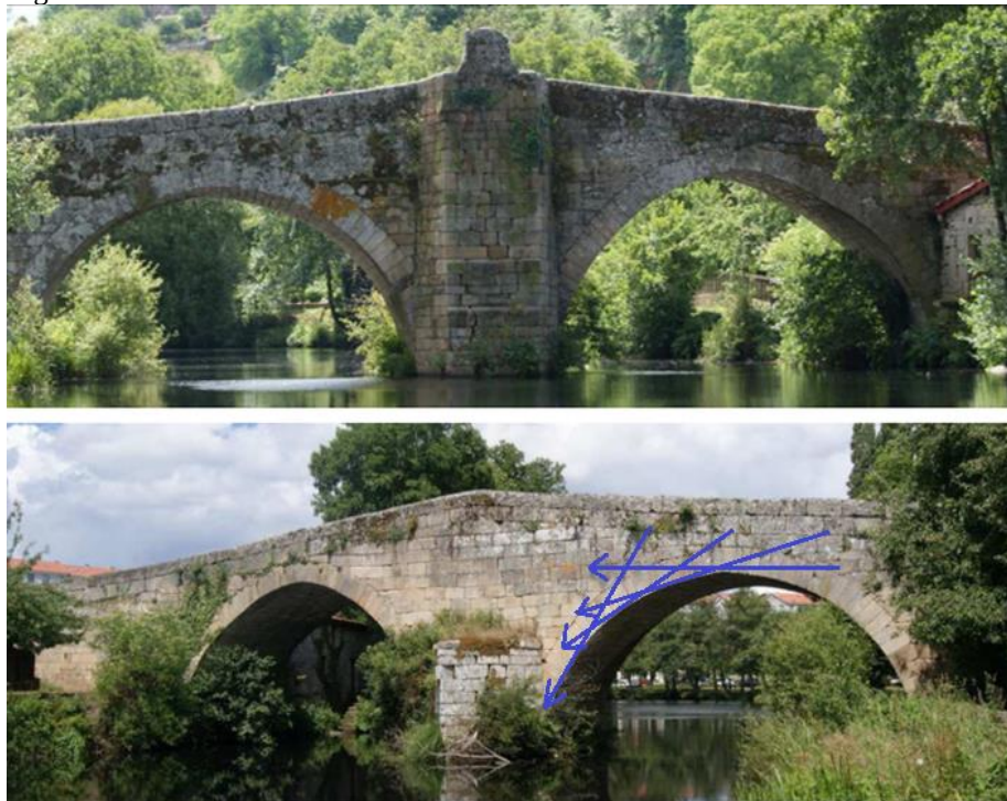
Figura 23 – Ponte de Vilanova: obra de arte em alvenaria.
