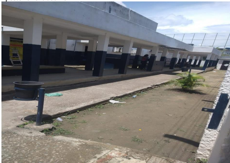
Figura 8 – Espaço interno onde se formam filas para a revista e posterior entrada no PAMFA
