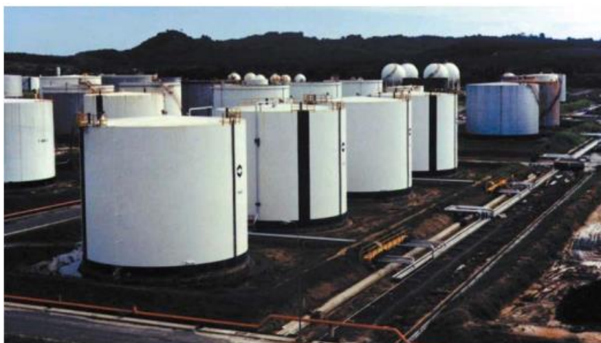
Figura 2 – Tanque de armazenamento com teto cônico.
