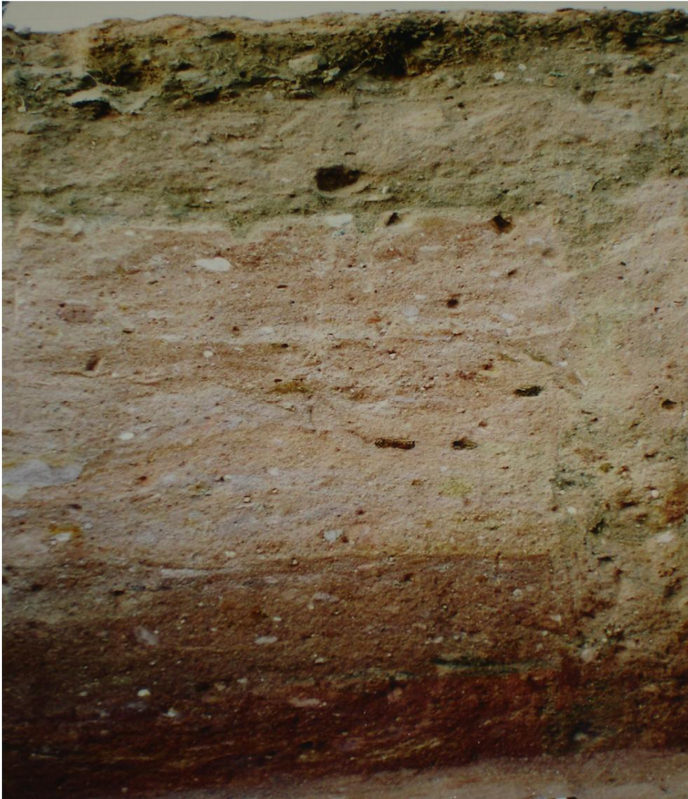
**Ilustração 8** – Estratigrafia do terreno. Pode-se ver as marcas dos aterros com material proveniente das barreiras existentes nos limites do Recife. O estrato mais escuro superior corresponde à sedimentação mais recente, de areia fina, com espessura de 40 cm. A sedimentação central de barro alaranjado mede 1 metro e a mais antiga, de barro vermelho, aparece na ilustração com 45 cm. Dez centímetros abaixo começou a brotar óleo.
