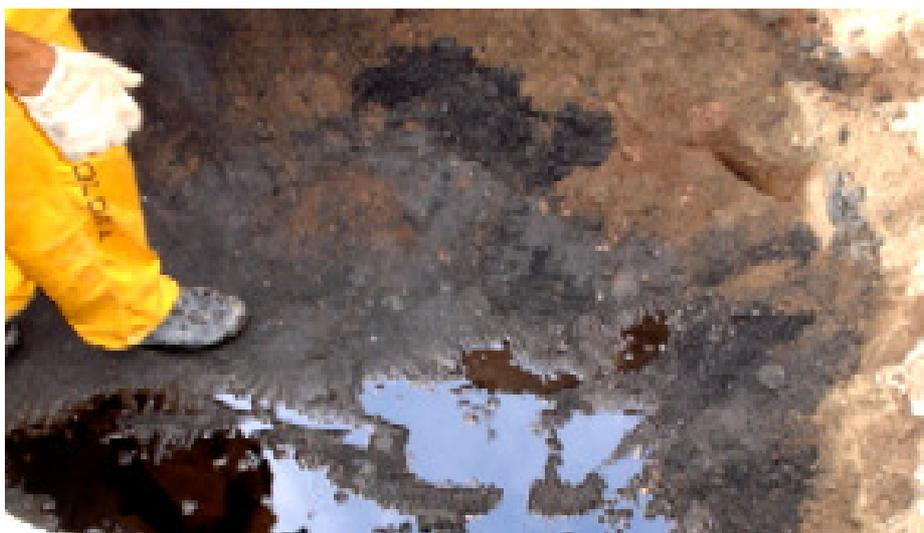
**Ilustração 9** – Após 2,3 m de profundidade do sedimento escavado começou a brotar do solo uma grande quantidade de óleo, impossibilitando a continuidade das escavações.
