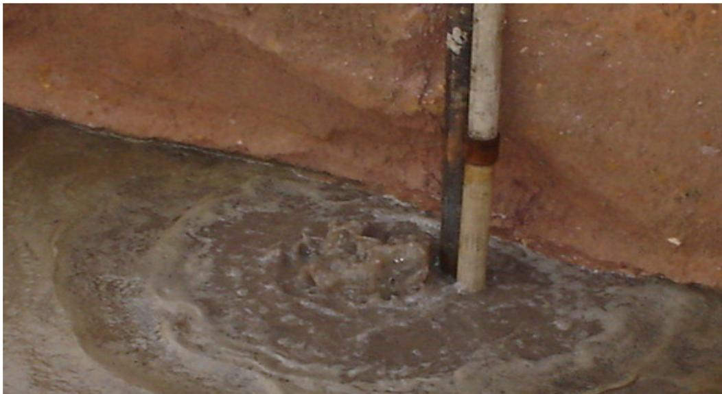
ilustração 35 – Perfuração do solo com tubo de aço para cravação de ponteiras.
