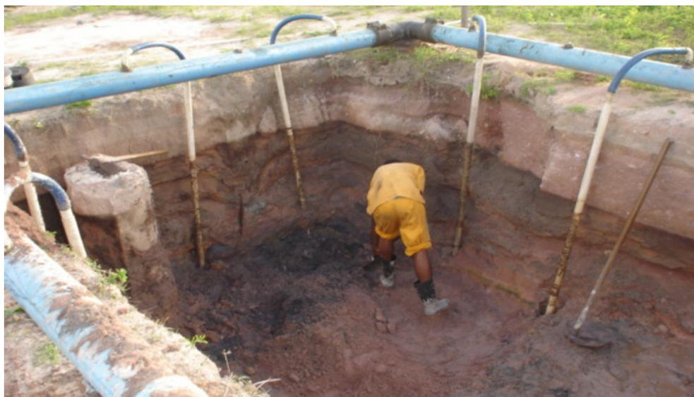
ilustração 36 - Esvaziamento da área a ser escavada. Nas paredes pode-se ver o nível em que estava a água antes das bombas serem acionadas
