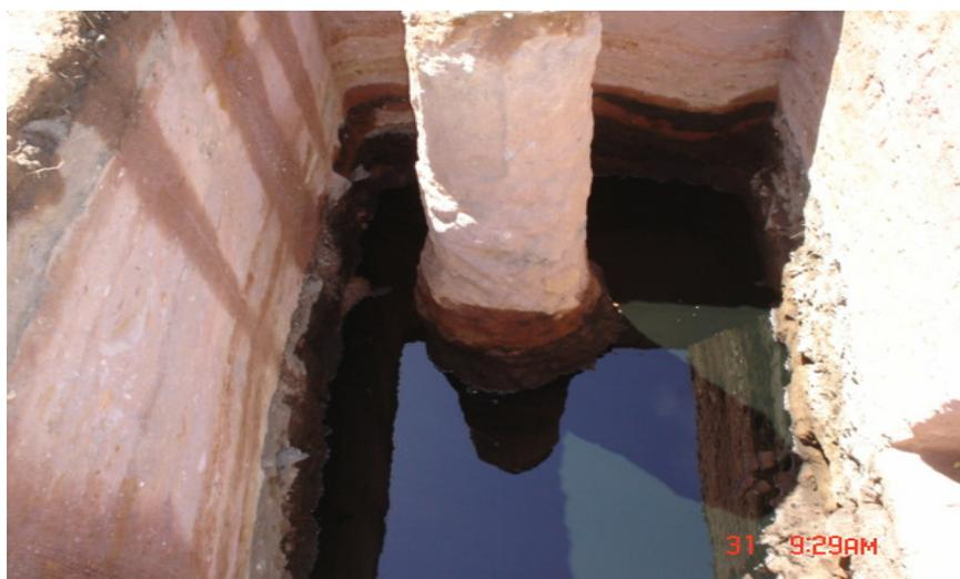
**Ilustração 10** – Quadrícula escavada repleta de óleo. Podemos ver a base de um dos pilares de sustentação da antiga passarela que havia para o abastecimento de gás dos antigos silos existentes no terreno.
