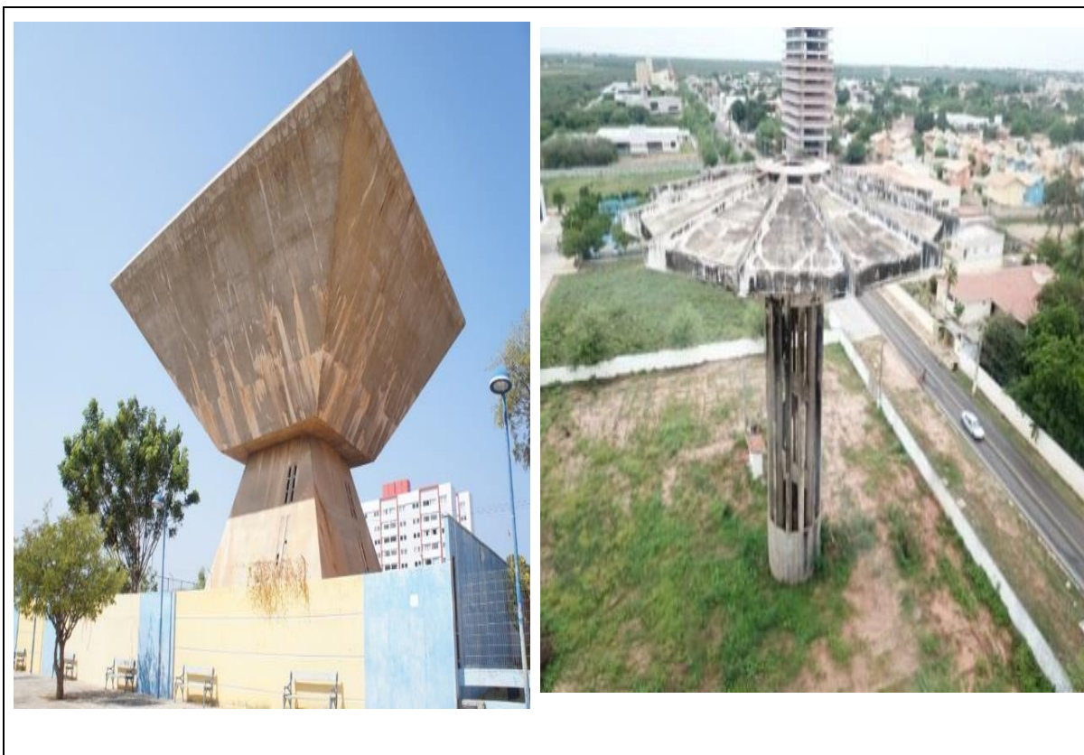
Figura 43 – Caixa D'água, Conjunto Abolição I, II, e Bairro Costa e Silva.
