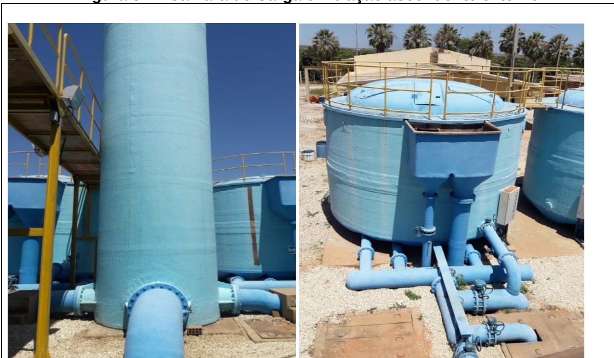
Figura 37 – Câmara de Carga e filtração ascendente externo.
