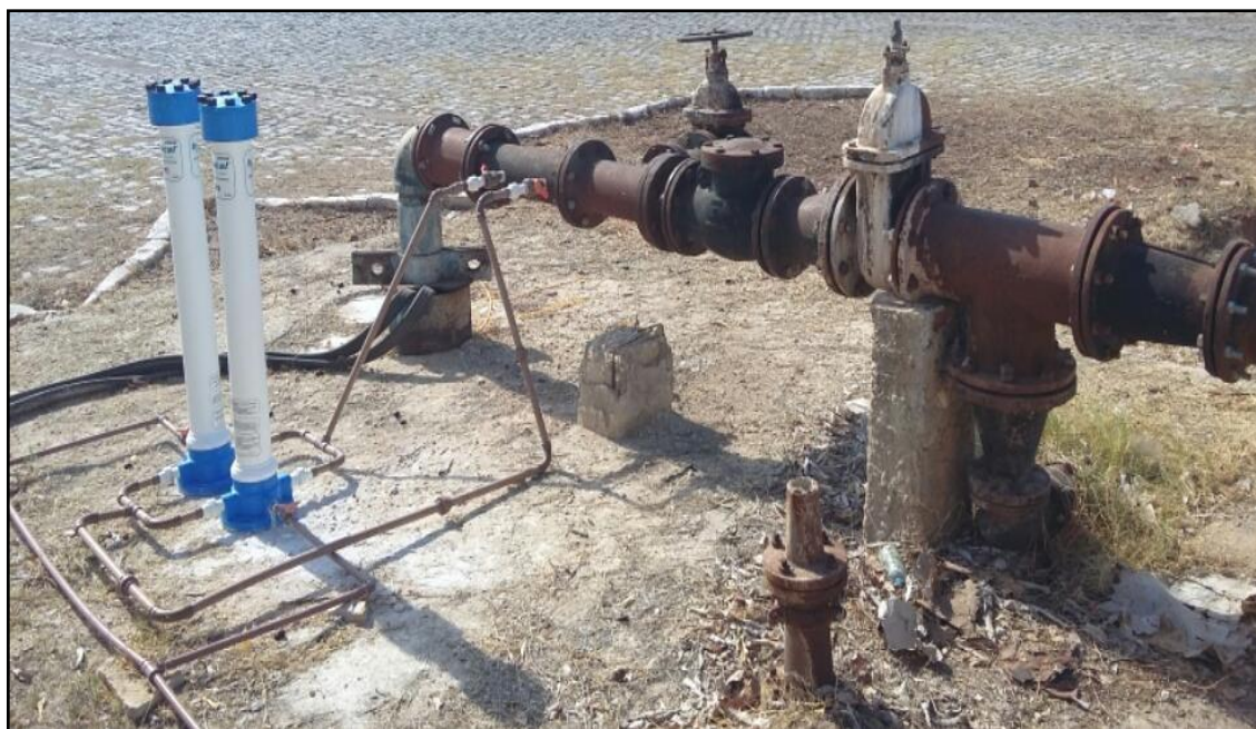
Figura 40 – Sistema de Cloro Pastilha.
