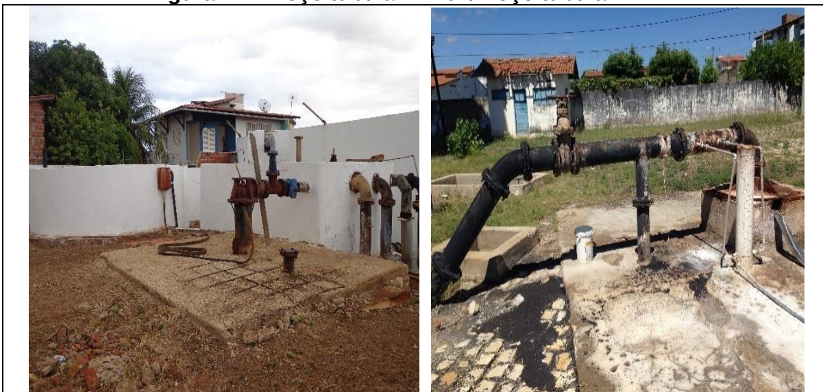
Figura 41 – Poço tubular PT-02/ Poço tubular PT-21.
