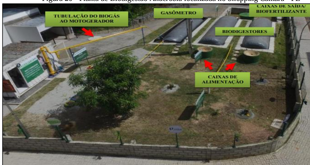
Figura 20 - Planta de Biodigestão Anaeróbia localizada no Shopping Camará - PE
