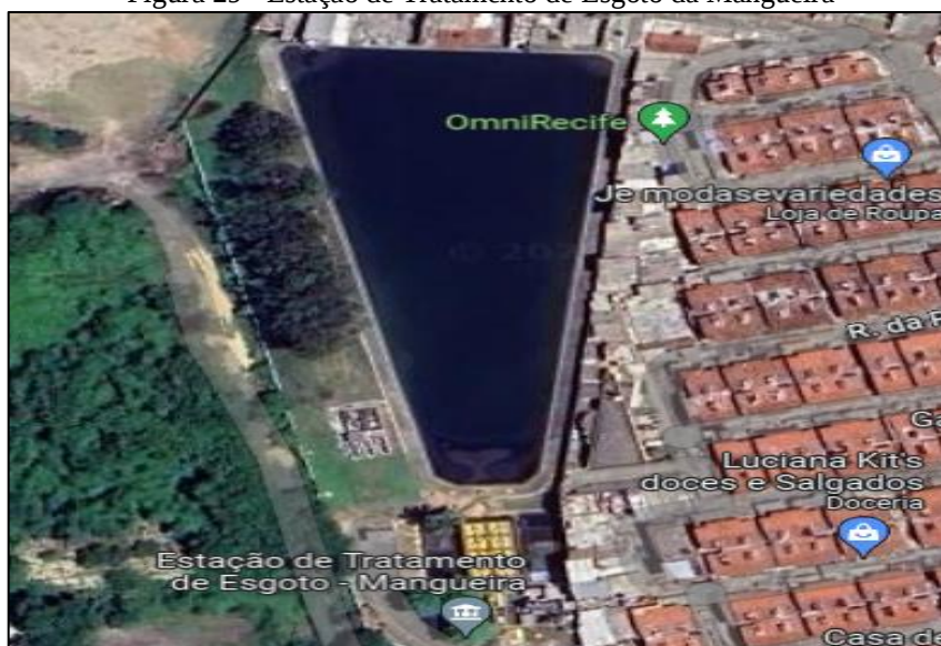
Figura 29 - Estação de Tratamento de Esgoto da Mangueira
