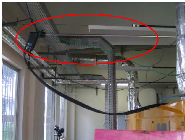
Figura 3.9 – Montagem da sonda de gases
