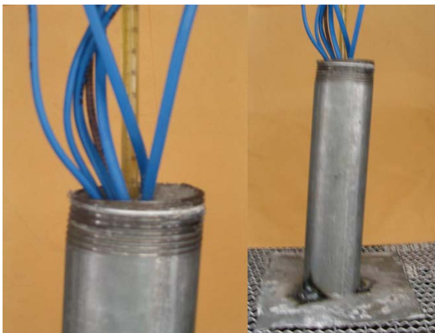
Figura 2.21 – Poço de estabilização
