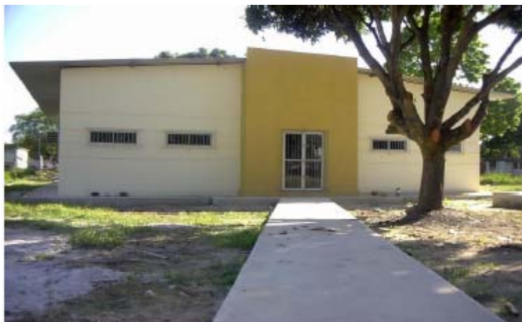
Figura 1.5 – Galpão onde está sendo instalado o sistema de cogeração Fonte: relatório interno do projeto COGENCASA
