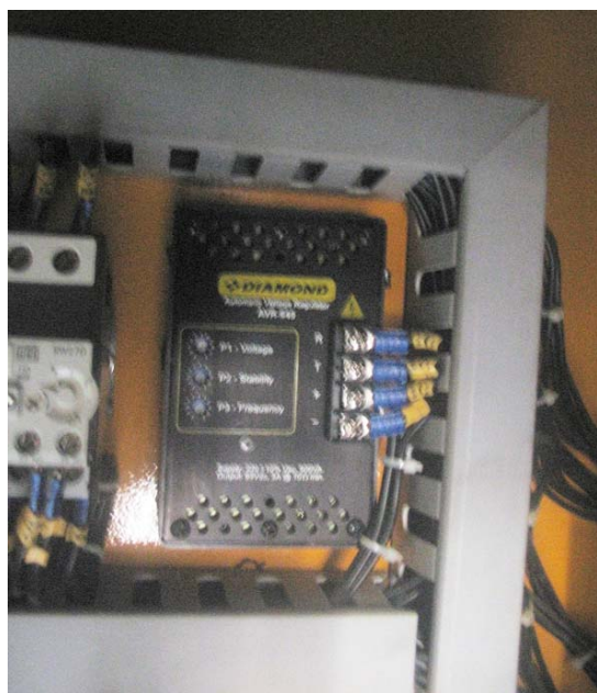
Figura 2.3 – Regulador de tensão
