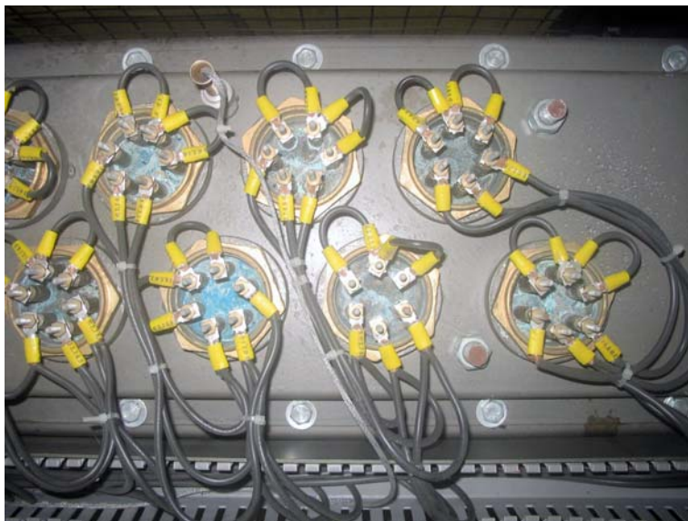
Figura 2.11 – Ligação elétrica das resistências
