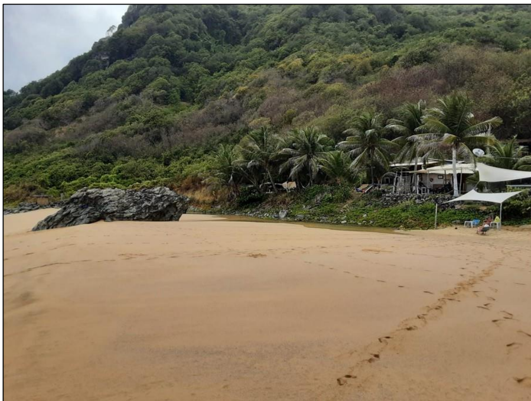
Figura 69 – Instalação de estrutura de alvenaria e madeira. Foto: Autor, 2021.
