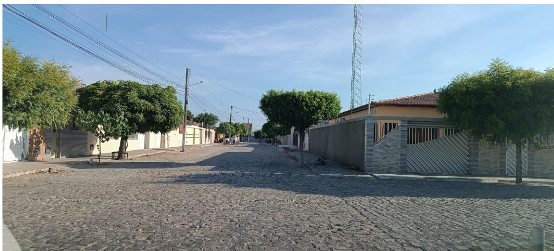
Figura 11 - Ruas do Bairro Princesinha do Oeste.
