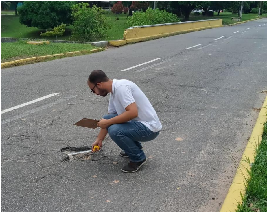
Figura 22 - Levantamento da condição do pavimento.
