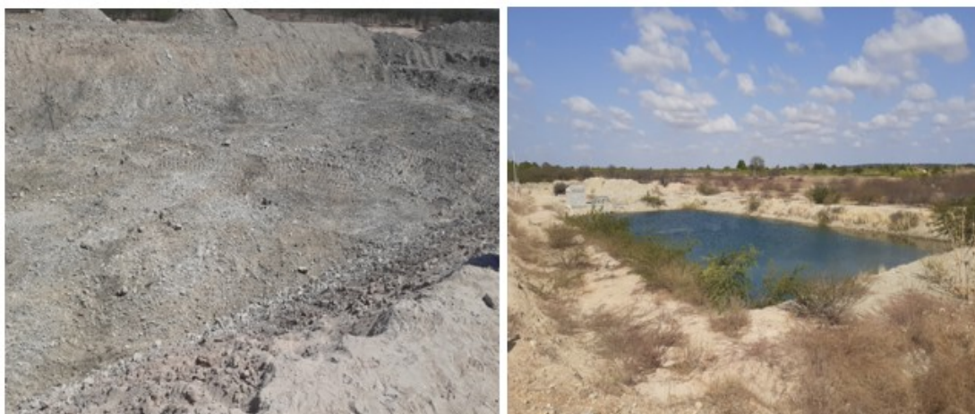
FIGURA 25 - OBRAS DO RESERVATÓRIO
