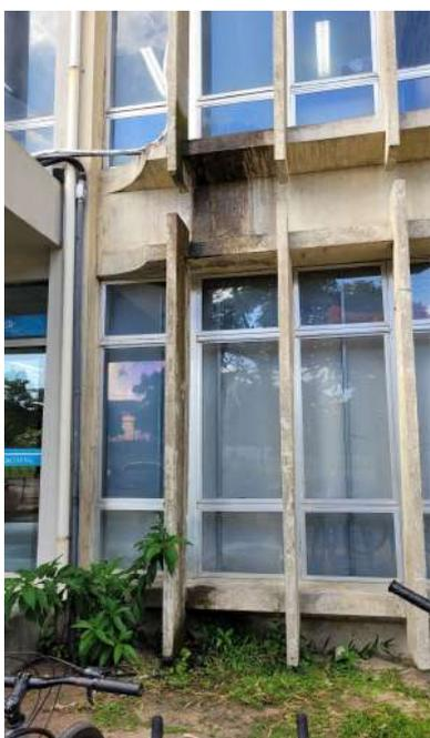
**Figura 101** | Água dos drenos escorrendo na fachada sul do edifício. Fonte: Autora, 2024.
