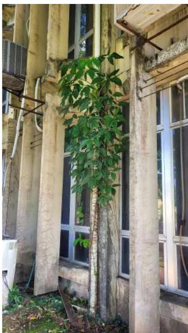
**Figura 112** | Disgregação dos Brises.
