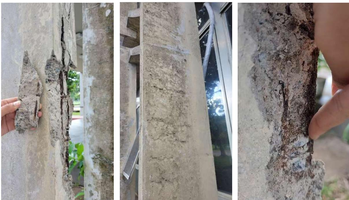
**Figura 105** | Deslocamento do revestimento da armadura. Fonte: Autora, 2024.
