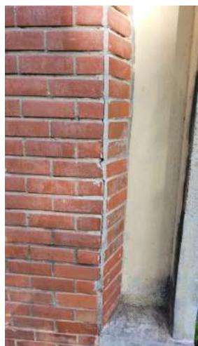
**Figura 108** | Fissuras e trincas nos Brises.
