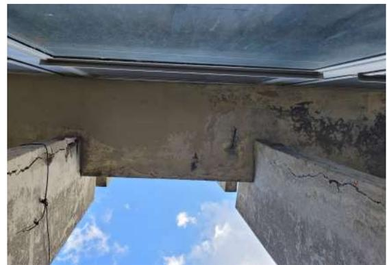
**Figura 98** | Destaque para os vitrais quebrados na fachada leste. Fonte: Autora, 2024.
