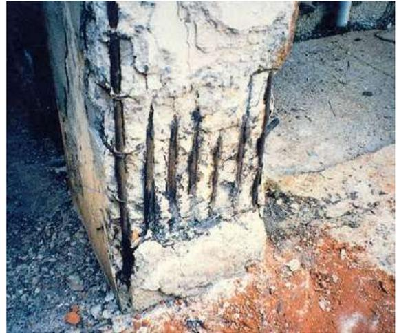
**Figura 25** | Corrosão das estruturas de ferro. Fonte: Coplas.
