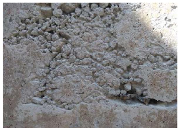
**Figura 27** | Concreto segregado. Fonte: Tecnosil.
