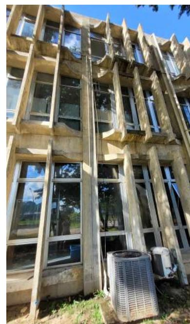
**Figura 103** | Infiltração na fachada sul do edifício. Fonte: Autora, 2024.
