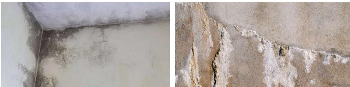
**Figura 21** | Infiltração na laje. Fonte: FiberSals.
