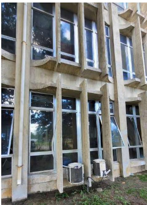
**Figura 104** | Condensadoras instaladas entre os Brises.
