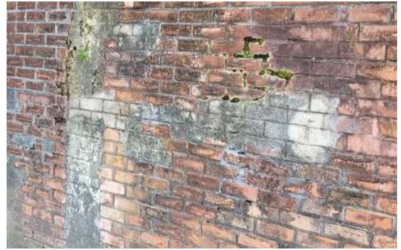
**Figura 96** | Janelas quebradas para a passagem de tubulação. Fonte: Autora, 2024
