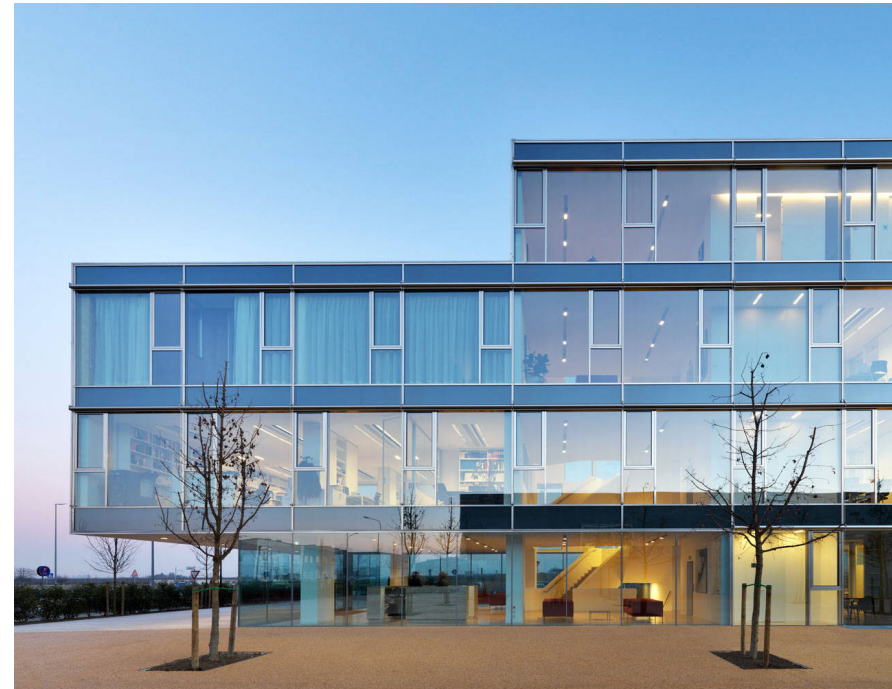
F24 - Características da fachada oposta.
