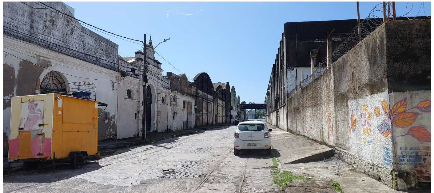
F11 – Fotografia dos armazéns (à esquerda) pela rua do Brum.
