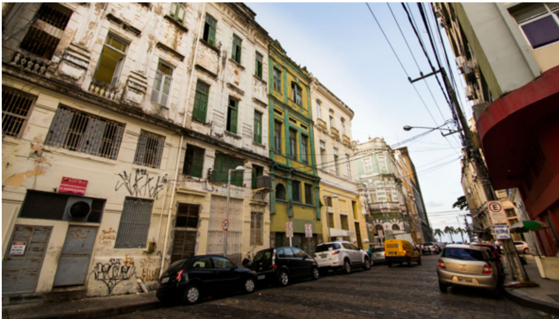
F05 - Processo de degradação do casario no Bairro do Recife.
