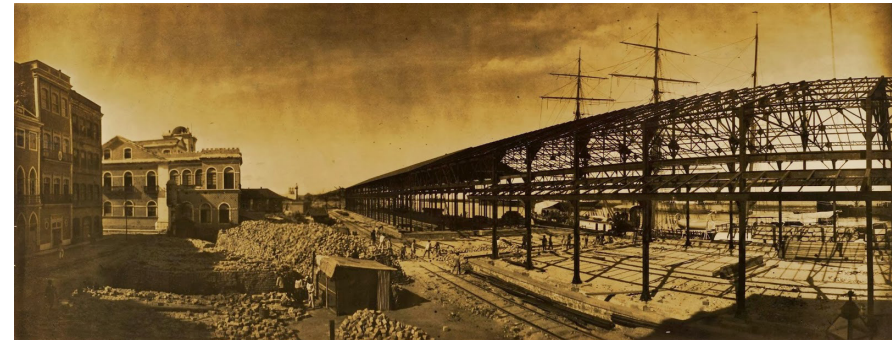
F02 - Reforma do porto do Recife: construção dos armazéns e docas.
