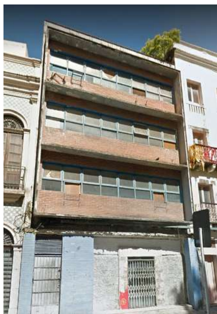
Figura 03: registro de 2011 da situação da fachada do prédio.
