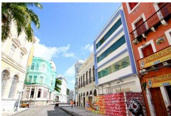
Figura 05: registro de 2021 da situação da fachada do prédio após sua reforma.
