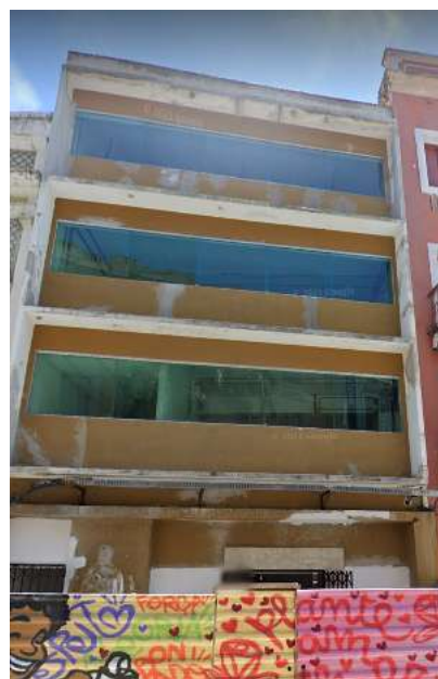
Figura 04: registro de 2020 da situação da fachada do prédio.
