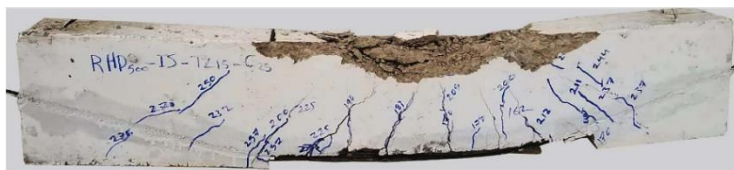
(d) Vista longitudinal na viga RHD 500 -TZ 15 -C 25
