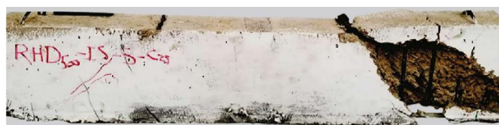
(f) Vista longitudinal na viga RHD 500 -S-C 25
