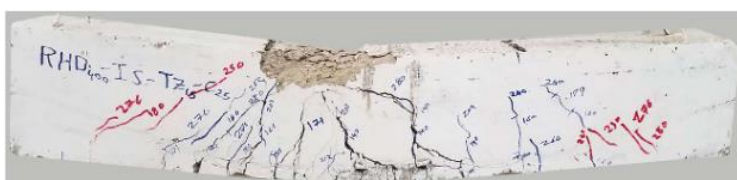
(a) Vista longitudinal na viga RHD 400 -TZ 15 -C 25
