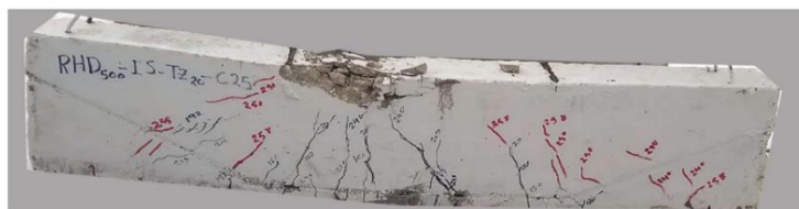
(e) Vista longitudinal na viga RHD 500 -TZ 25 -C 25
