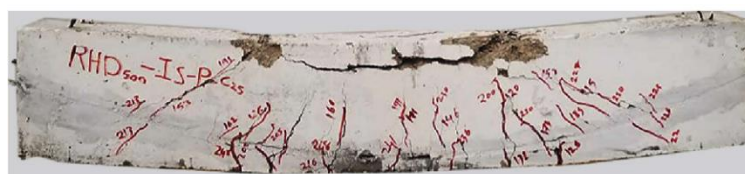
(g) Vista longitudinal na viga RHD 500 -P-C 25
