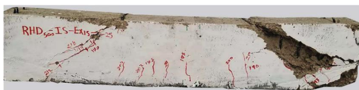
(h) Vista longitudinal na viga RHD 500 -TZEX 15 -C 25
