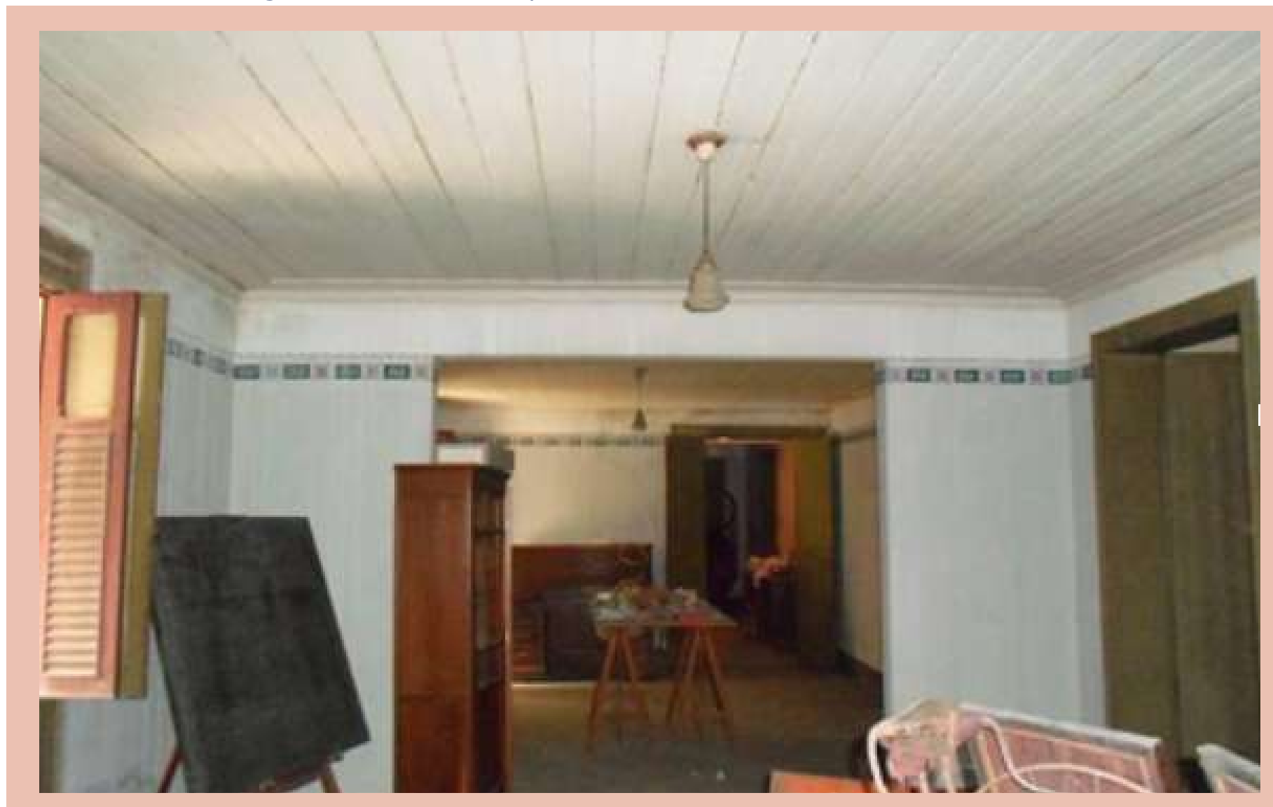
Imagem 31: Salas do pavimento térreo do imóvel.
