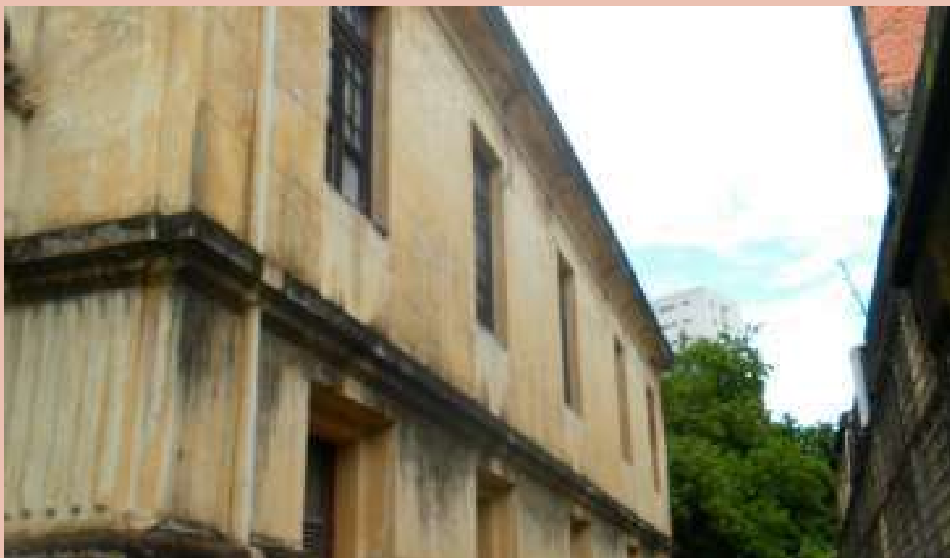
Imagem 24: Aberturas em madeira e vidro na fachada lateral (sul)
