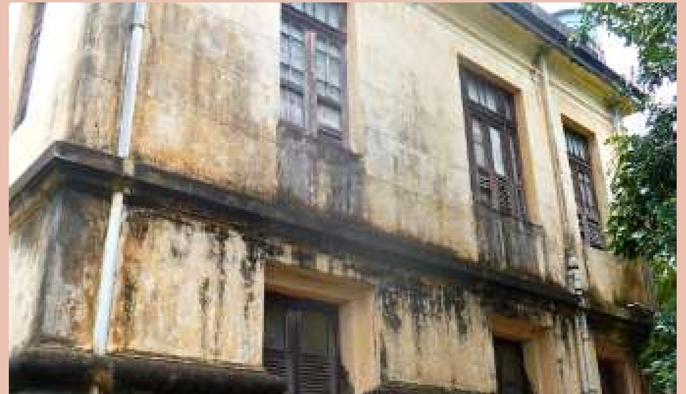
Imagem 25: Aberturas em madeira e vidro na fachada posterior (leste)
