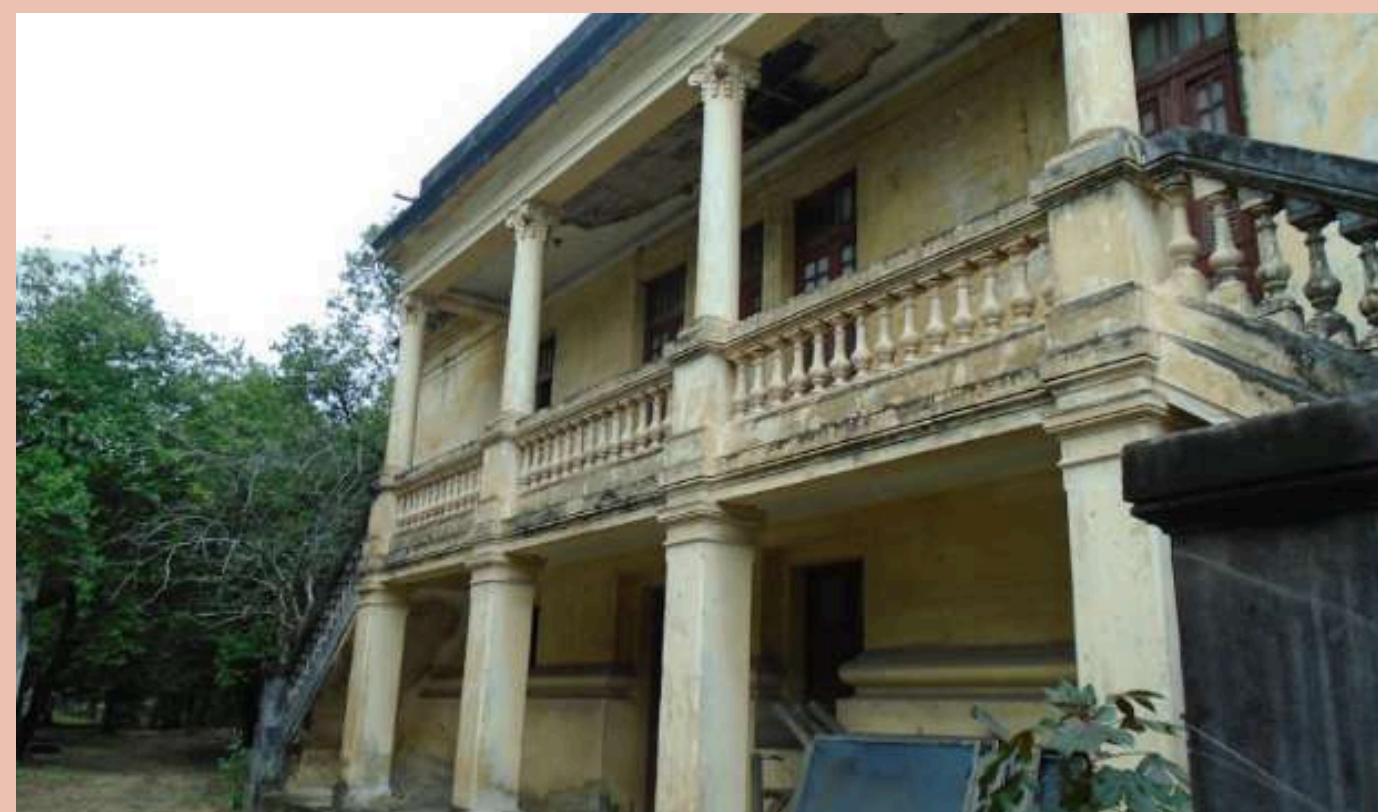
Imagem 22: Fachada lateral (norte)
