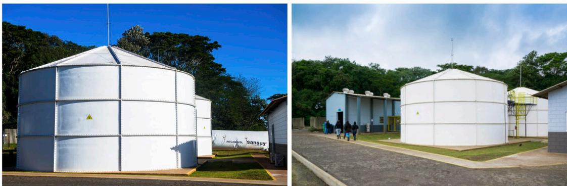
Biodigestor CSTR localizado na UD Itaipu, Foz do Iguaçu – PR.
