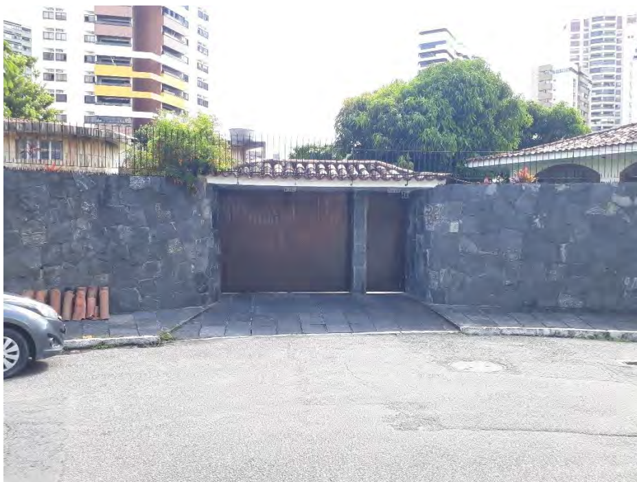
Figura 48: Fachada cega de edificação residencial, na Rua Afonso Celso. Fonte: acervo pessoal. Junho, 2023.
