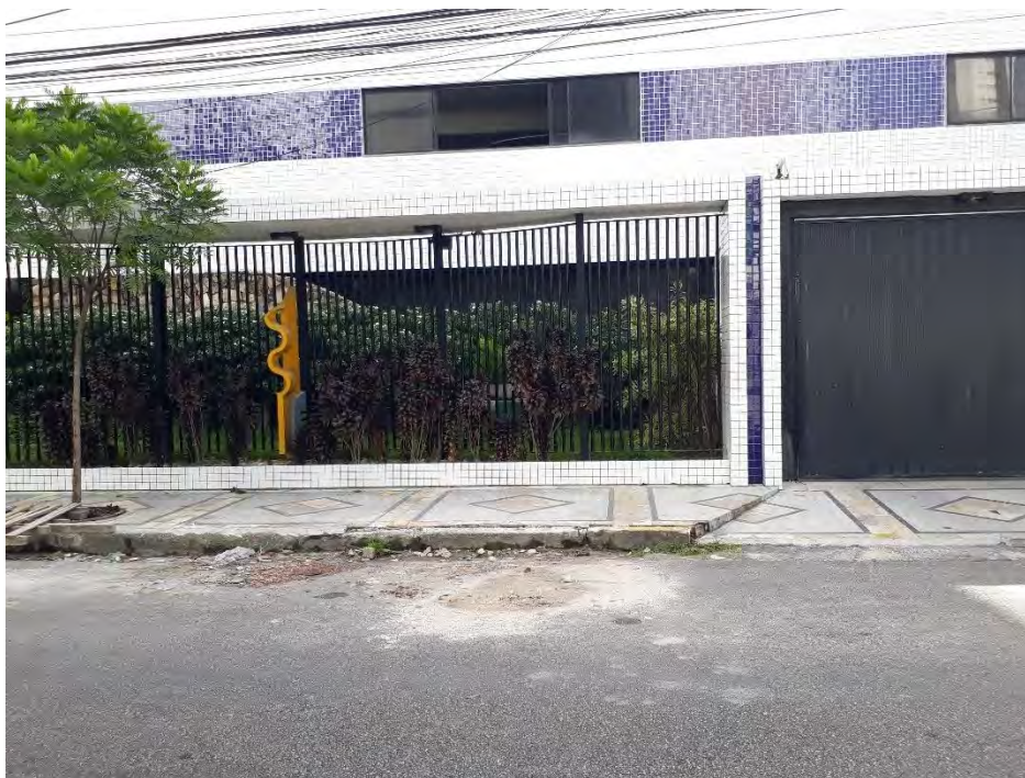
Figura 38: Fachada ativa a de edificação residencial, na Rua Afonso Celso. Fonte: acervo pessoal. Junho, 2023.
