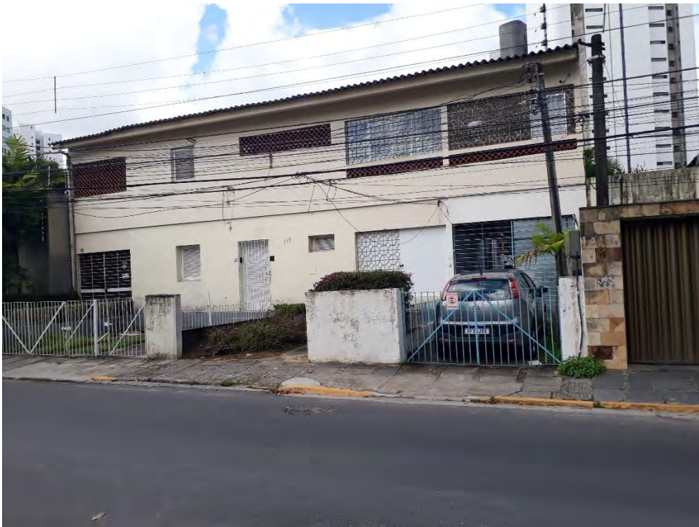
Figura 37: Fachada ativa de edificação residencial, na Rua Albino Meira. Fonte: acervo pessoal. Junho, 2023.
