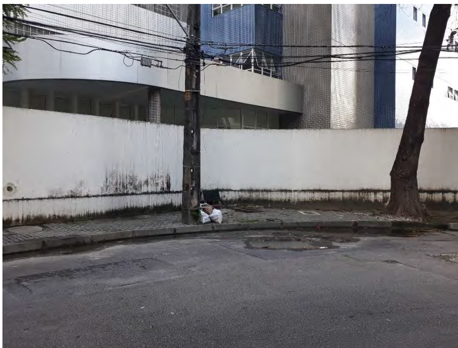
Figura 45: Fachada cega do Hospital Agamenon Magalhães, na Rua Afonso Celso. Fonte: acervo pessoal. Junho, 2023.
