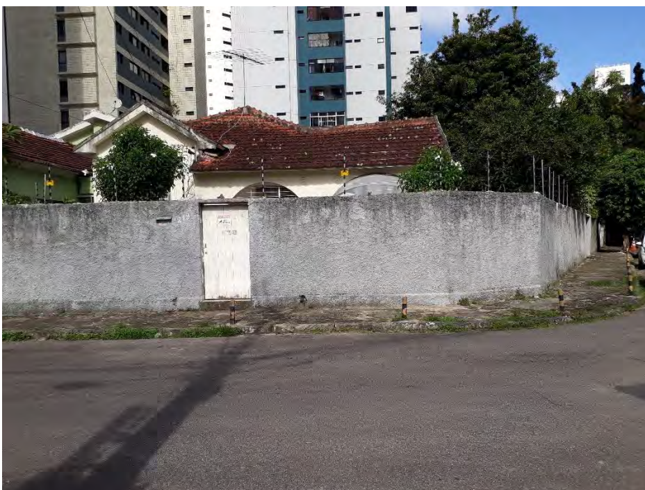
Figura 49: Fachada cega de edificação residencial, na Rua Afonso Celso. Fonte: acervo pessoal. Junho, 2023.
