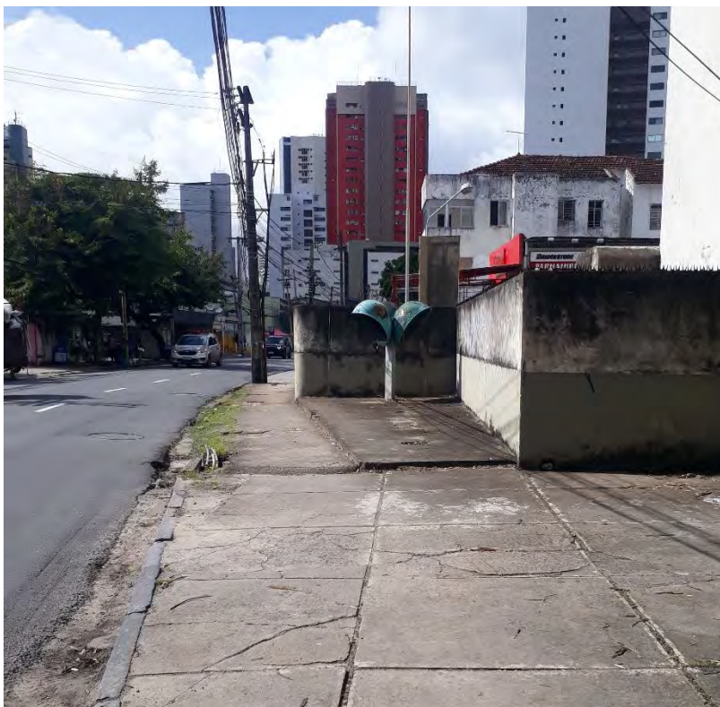
Figura 25: Trecho de calçada da Estrada do Arraial. Fonte: acervo pessoal. Julho, 2023.
