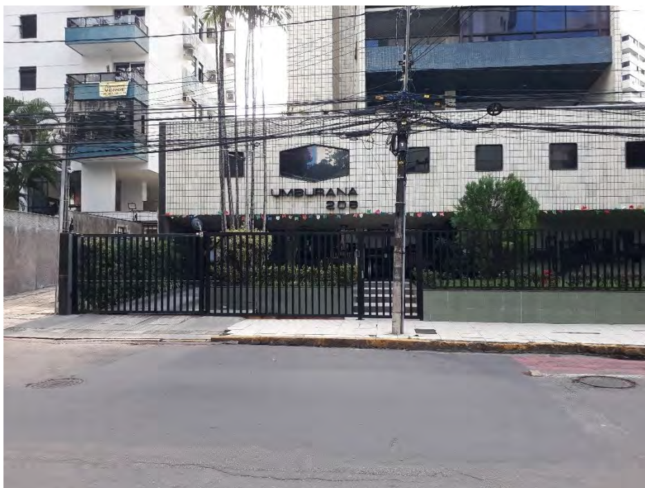
Figura 40: Fachada ativa de edificação residencial, na Rua Sebastião Alves. Fonte: acervo pessoal. Junho, 2023.
