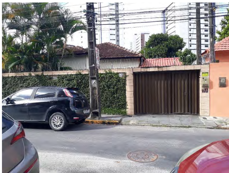
Figura 47: Fachada cega de edificação residencial, na Rua Albino Meira. Fonte: acervo pessoal. Junho, 2023.
