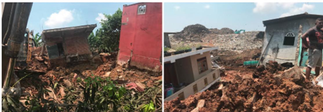
**Figura 3.1:** Colapso de aterro sanitário no Sri Lanka. Entre as causas prováveis, há a decomposição do lixo eletrônico.
