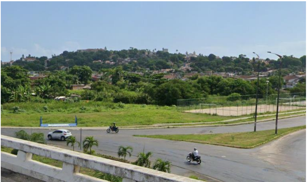
Figura 13 – Viaduto localizado em Olinda, entre o cruzamento das Avenidas Pan Nordestina e Presidente Kennedy.
