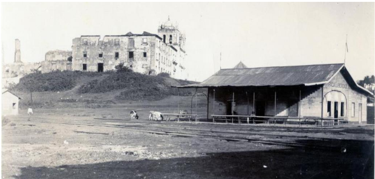
Figura 28 – Vista do pátio da estação ferroviária. Ao fundo o Convento de Santo Antônio em estado de arruinamento e a Igreja do Carmo.
