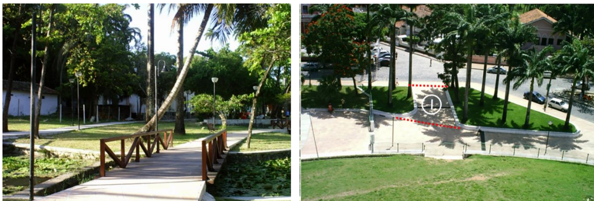
Figura 51 – Vista da Ponte no lado do Sítio de Seu Reis, nota-se que a sementeira foi demolida. 1. Criação de novo acesso a colina com recorte do canteiro. Na foto destacam-se as palmeiras-imperiais ( Roystonea oleracea ) e espatódea ( Spathodea campanulata ).
