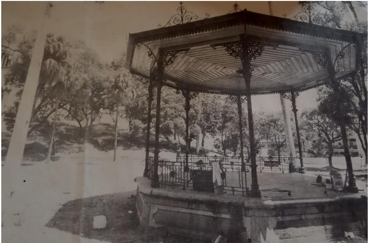
Figura 41- “Conservação de Olinda gera polêmica” como retrato do abandono e má conservação do Centro Histórico de Olinda, onde o coreto apresenta estrutura de ferro corroída e gradil com peças ausentes.
