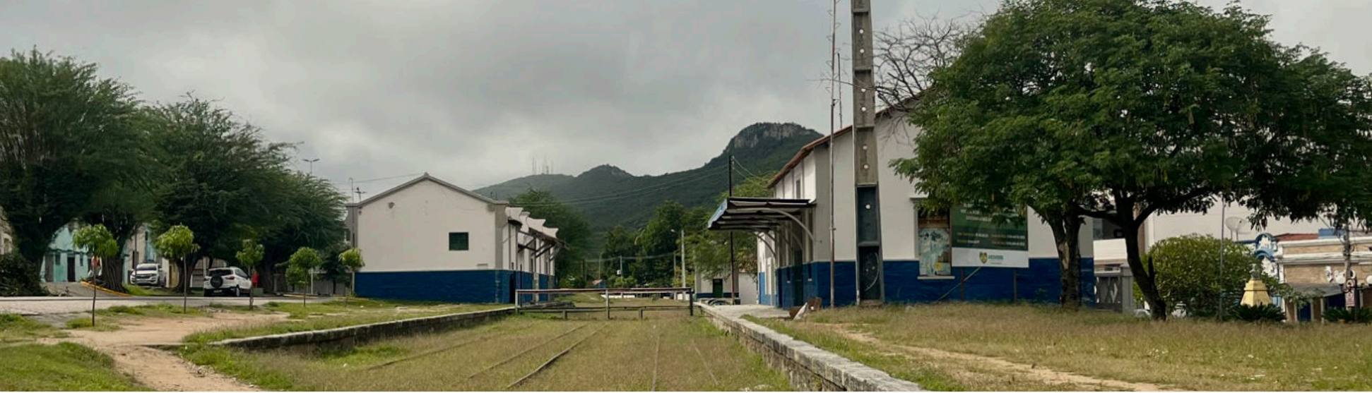
Figura 79 - Imagem geral mostrando os edifícios existentes
