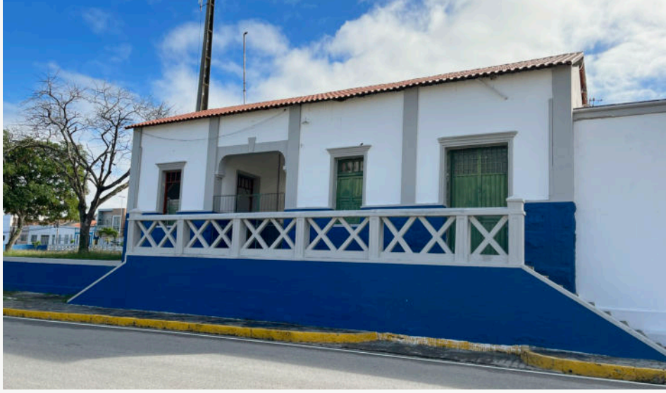
Figura 81 - Imagem mostrando a frente da estação
