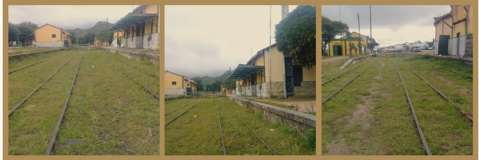
Figura 25 - Imagens do terreno, trilhos e edificações da antiga estação
