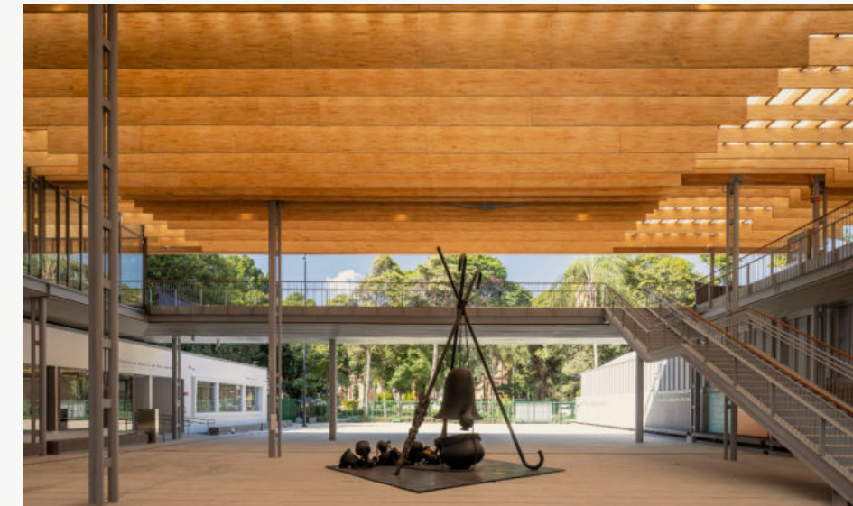
Figura 57 - Vista da Pina Contemporânea olhando para o jardim, abaixo de sua cobertura
