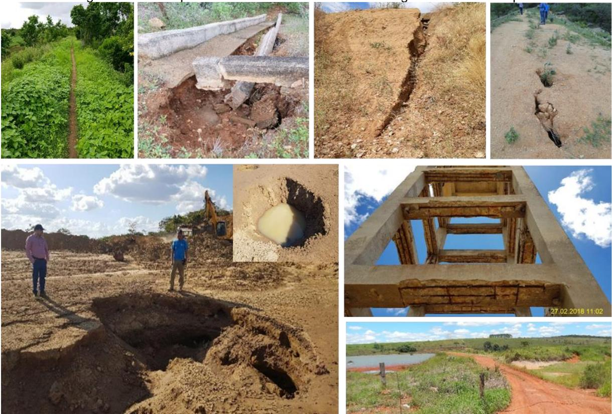
Da esquerda para a direita, de cima para baixo: excesso de vegetação na barragem, erosões e deficiências no sistema de drenagem superficial, rachaduras, buracos e cavidades, *pipping* e vazamentos, deterioração do concreto e obstrução de vertedor.
