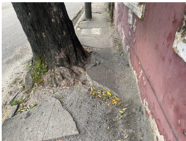
Figura 11: Raíz de árvore interferindo nas condições físicas do passeio. Fonte: Costa, 2023.
