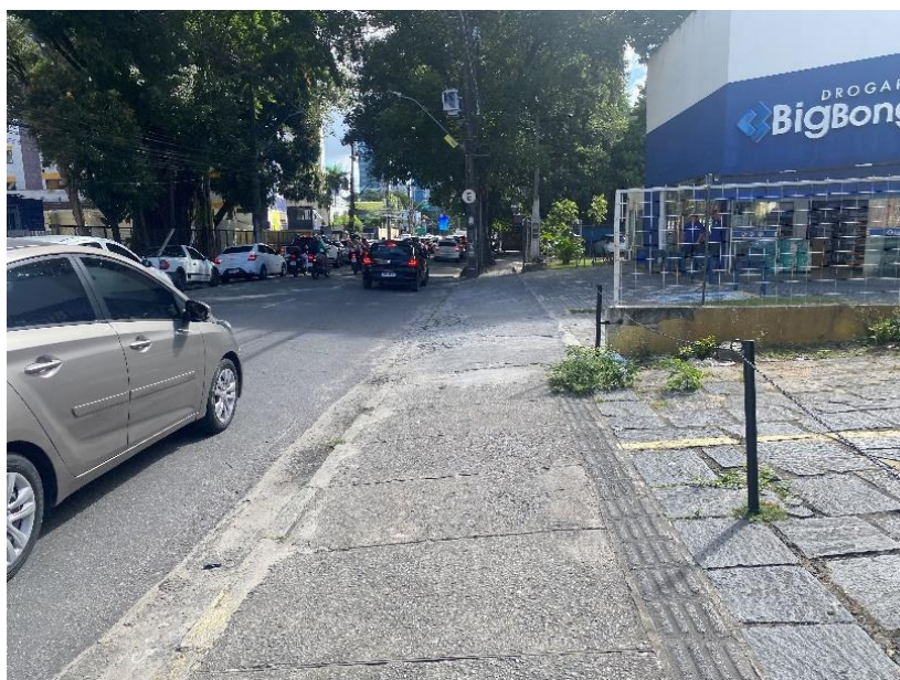
Figura 12: Balizadores com corrente separando o passeio da entrada de veículos. Fonte: Costa, 2023.
