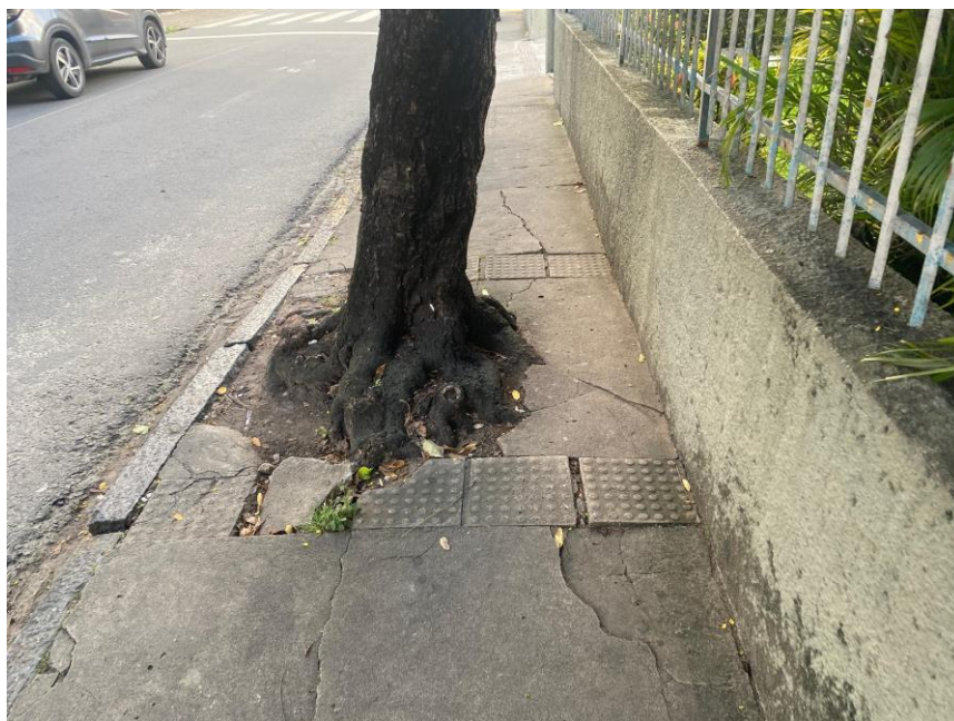
Figura 1: Sinalização tátil entre árvore e muro. Fonte: Costa, 2023.
