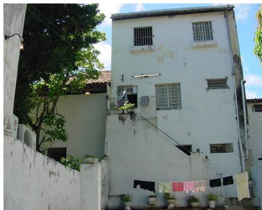
**Imagem 8** Acréscimo de pavimento, com descharacterização e sobrecarga estrutural.
