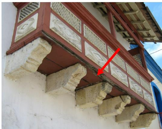
**Imagem 7** Desagregação de materiais na fachada principal de sobrado mourisco.
