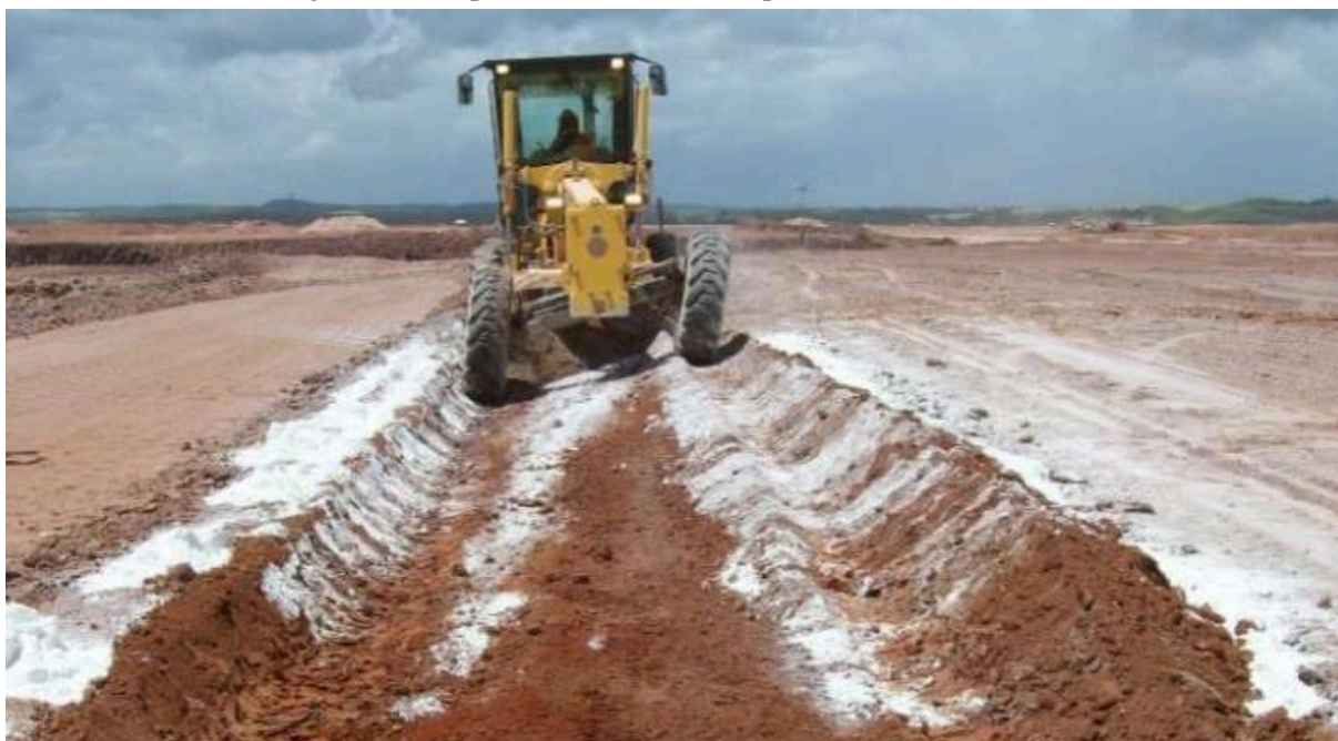
Figura H.7 - Aplicação de cal com espalhamento mecanizado.
