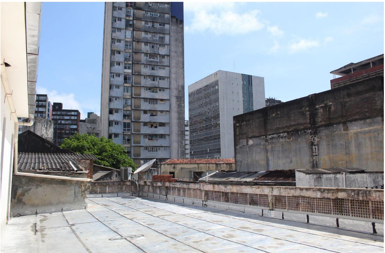
Figura 54. Vista do antigo terraço, com piso removido e com vão central que separava terraço da varanda de serviço fechado por questões de infiltração.
