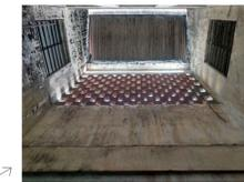
Vista interna da cobertura do poço a partir do primeiro pavimento. Notar solução com "cobogós improvisados" em tijolo na empresa para entrada de iluminação
