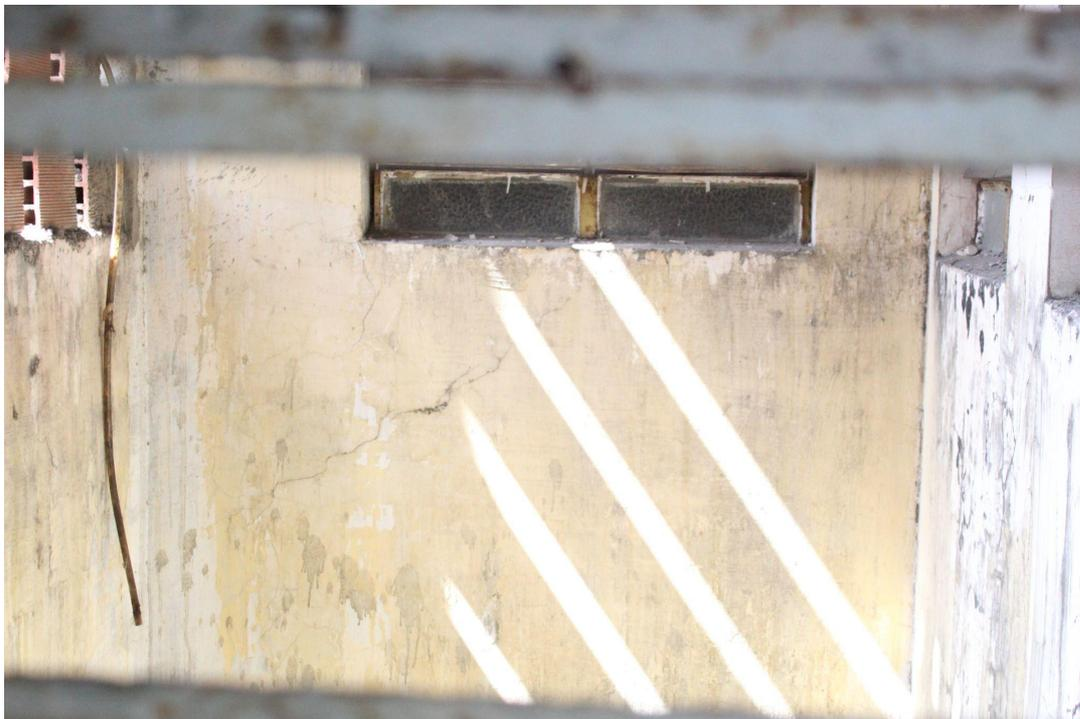
Figura 66. Marcas de sol atravessando “cobogó improvisado” em tijolos, na empena.
