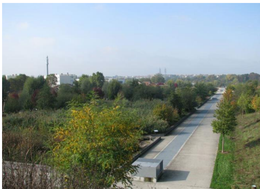
Figura 2 - Vista geral das bacias filtrantes.
