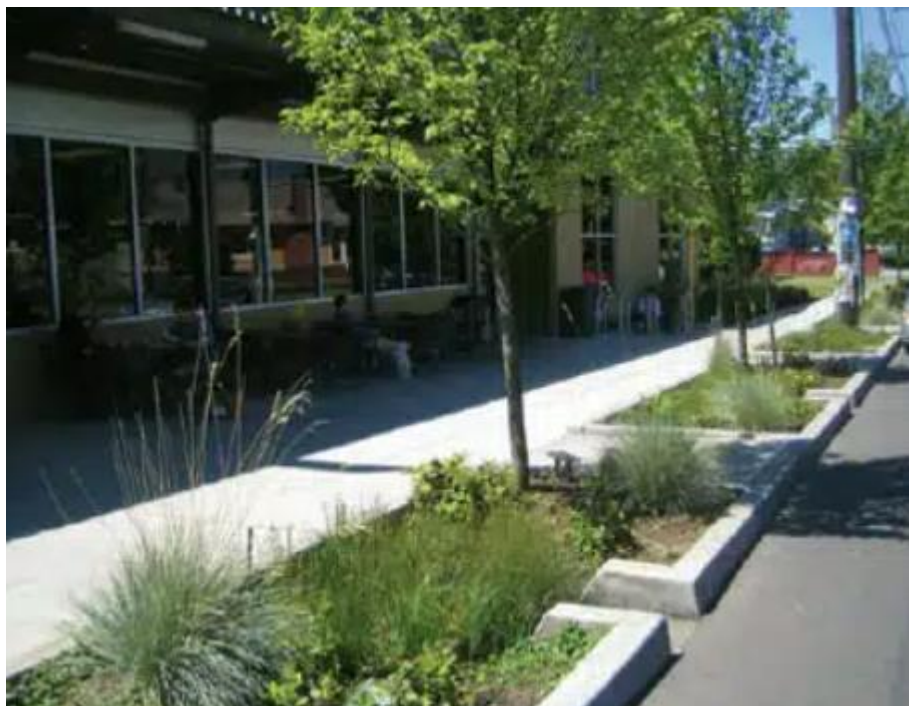
Figura 6 - Canteiros Pluviais em Portland, Oregon, EUA.
