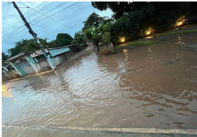
Figura 14: Rua das Pedrinhas, após forte chuva.
