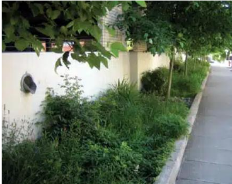
Figura 7 - Canteiros Pluviais em Portland, Oregon, EUA.
