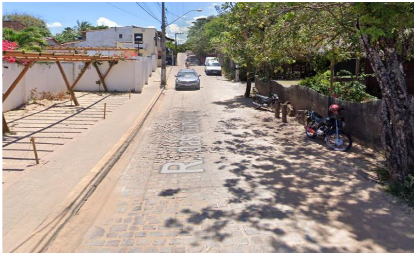
Figura 18 - Ponto de alagamento em período sem ocorrência de chuva.
