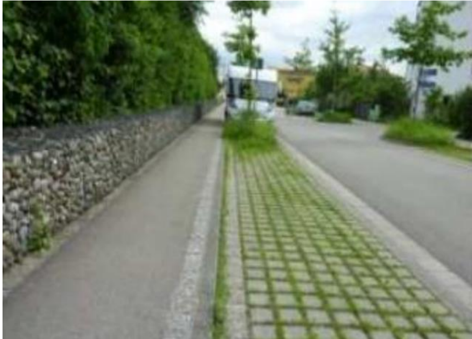
Figura 4 - Pavimento permeável em Freiburg, Alemanha.
