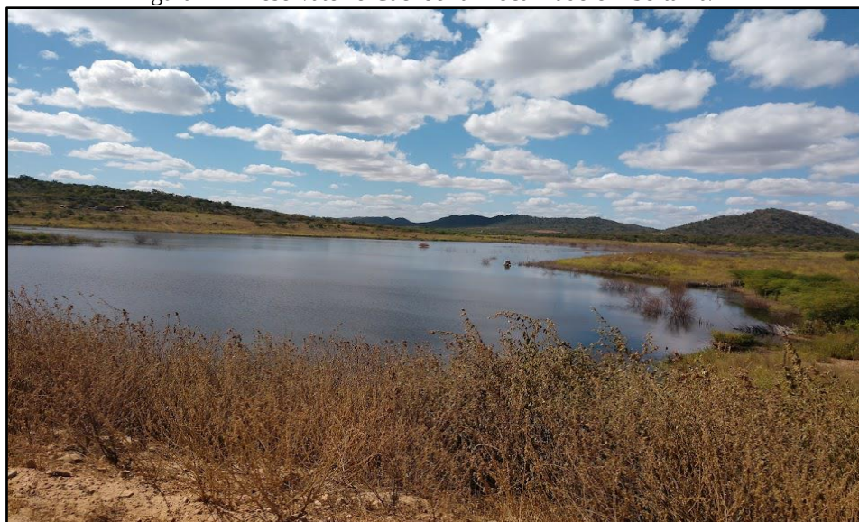
Figura 41 - Reservatório Cachoeira I localizado em Sertânia/PE
