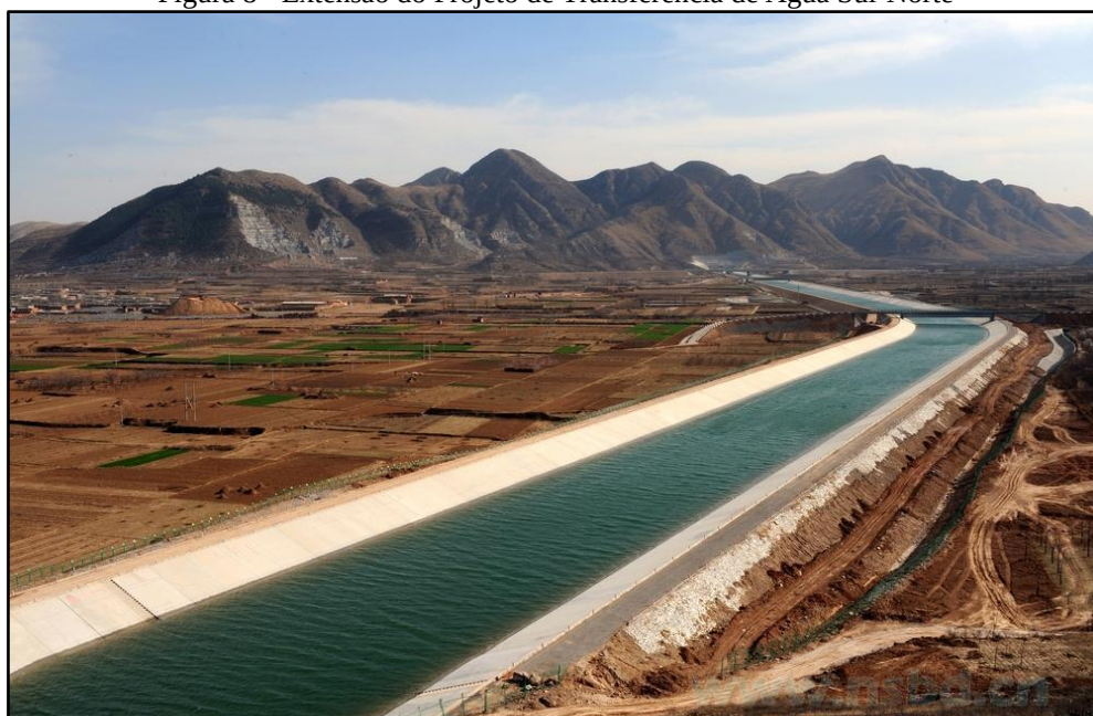
Figura 8 - Extensão do Projeto de Transferência de Água Sul-Norte
