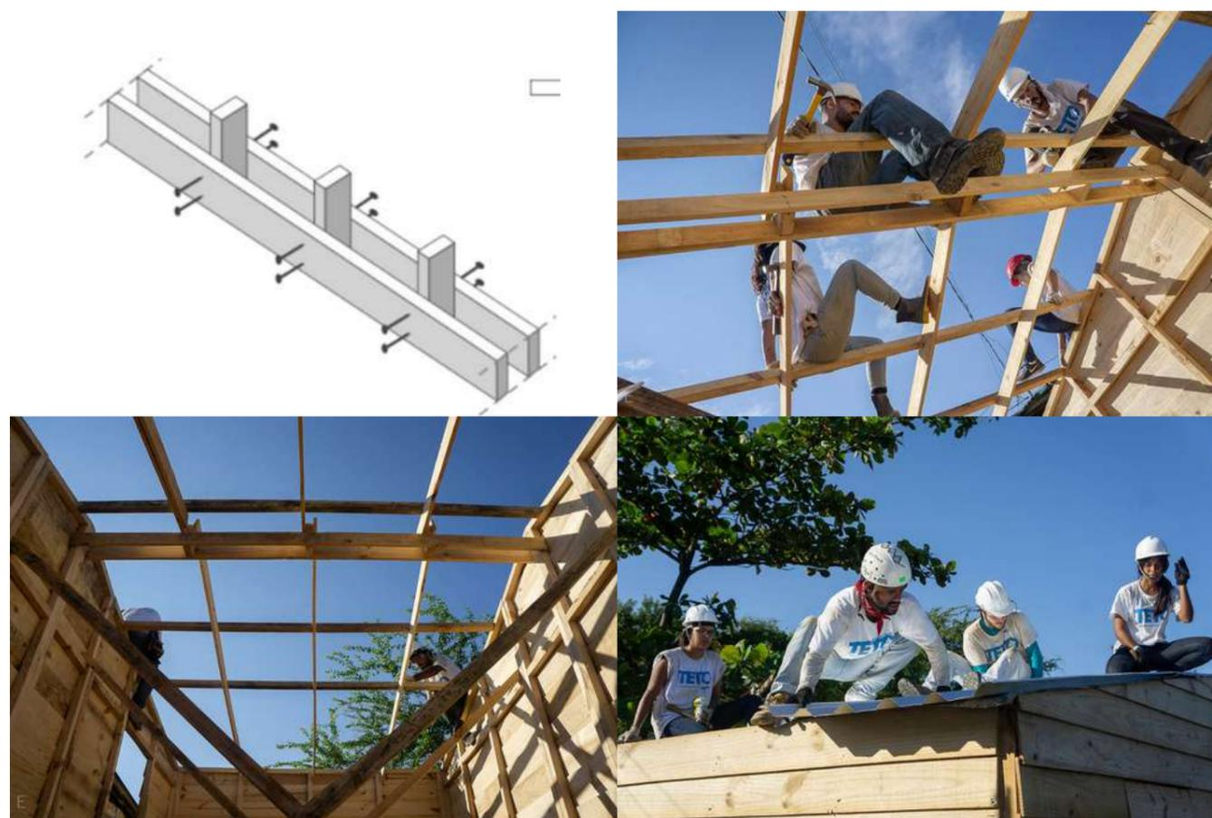
Figura : Ilustração da viga mestra; Levantamento fotográfico Execução da estrutura do telhado
