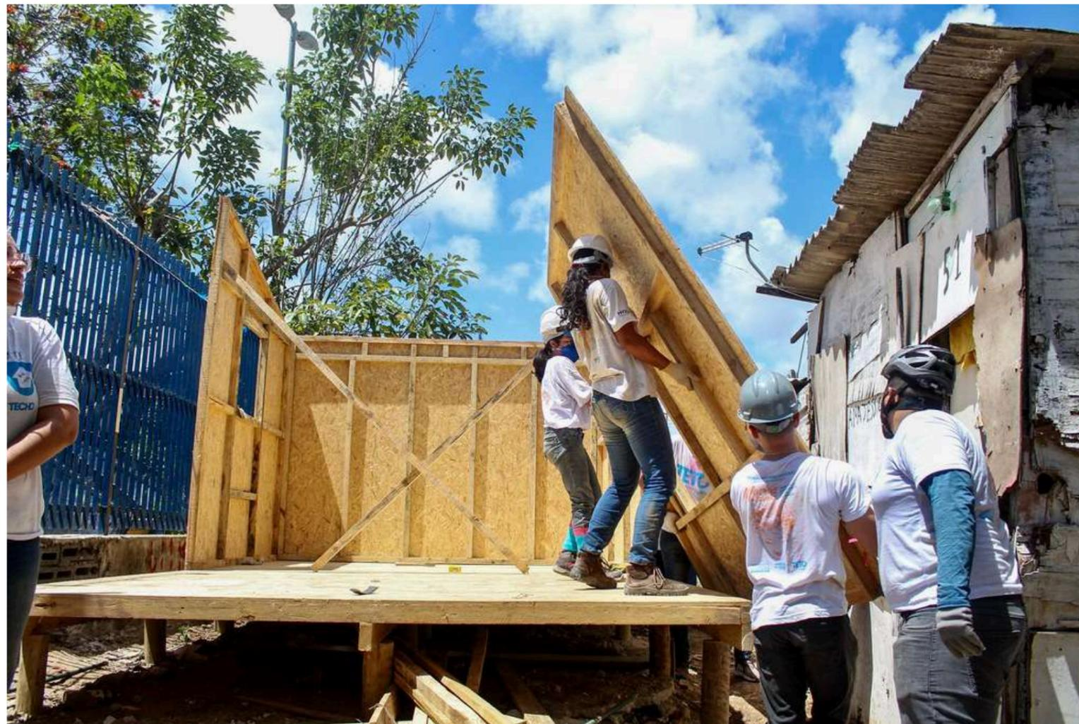
Figura : Posicionamento dos painéis pré-fabricados de parede
