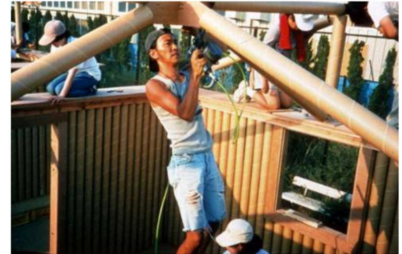
Figura: Construção das Paper log Houses em Kobe, Japão.
