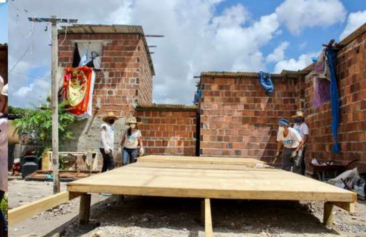
Figura : Processo de execução da fundação e fixação dos pisos
