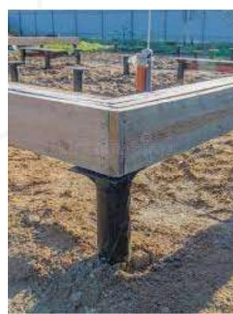
Figura : Base de aço galvanizado
