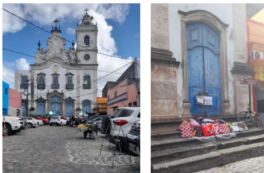
Figura 105: Pátio e igreja de São José do Ribamar; Figura 106: Porta da igreja de São José do Ribamar - detalhe das almofadas. Fonte: Autora (2023)
