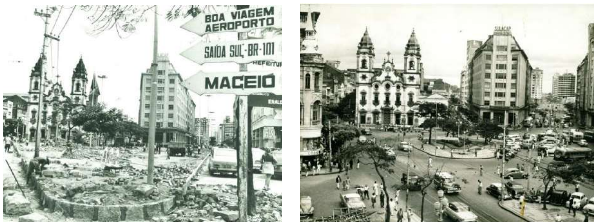
Figura 205: obras da Praça do Diário, 1974; Figura 206: Vista ampla da Praça, com os prédio da Sulacap e a Avenida Guararapes no lado direito.
