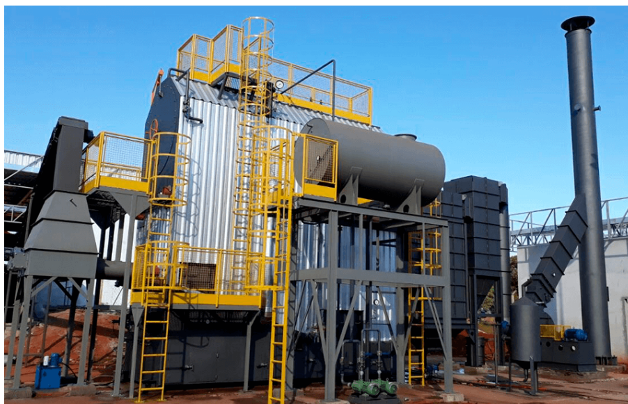
Figura 3.3 - Caldeira flamotubular.
