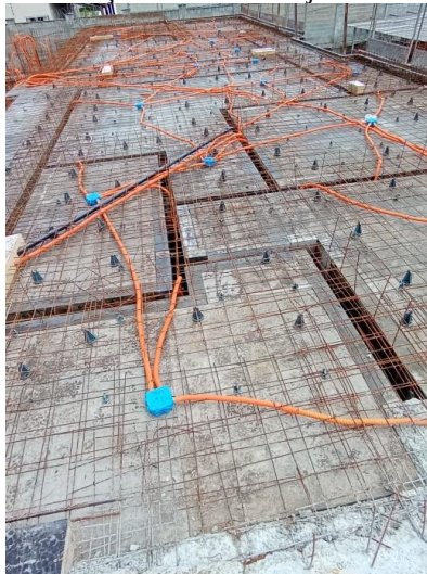
Figura 5 – Conduítes para instalação elétrica em laje no sistema de paredes de concreto
