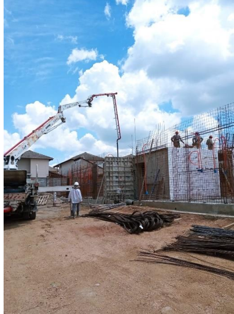
Figura 9 – Concretagem utilizando bomba lança
