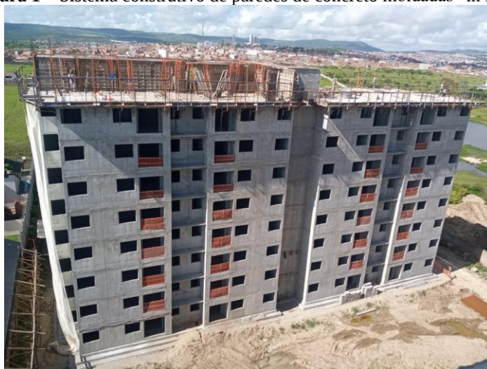
Figura 1 – Sistema construtivo de paredes de concreto moldadas “in loco”
