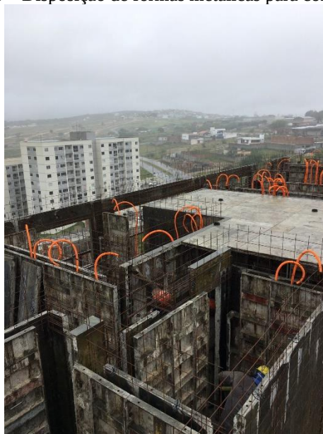
Figura 3 – Disposição de fôrmas metálicas para concretagem
