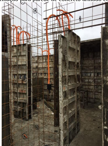
Figura 4 – Armação para parede de concreto armado com espaçadores
