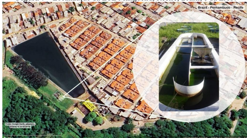
Figura 7 - Localização da ETE Mangueira, Recife, Brasil, e da LAT.
