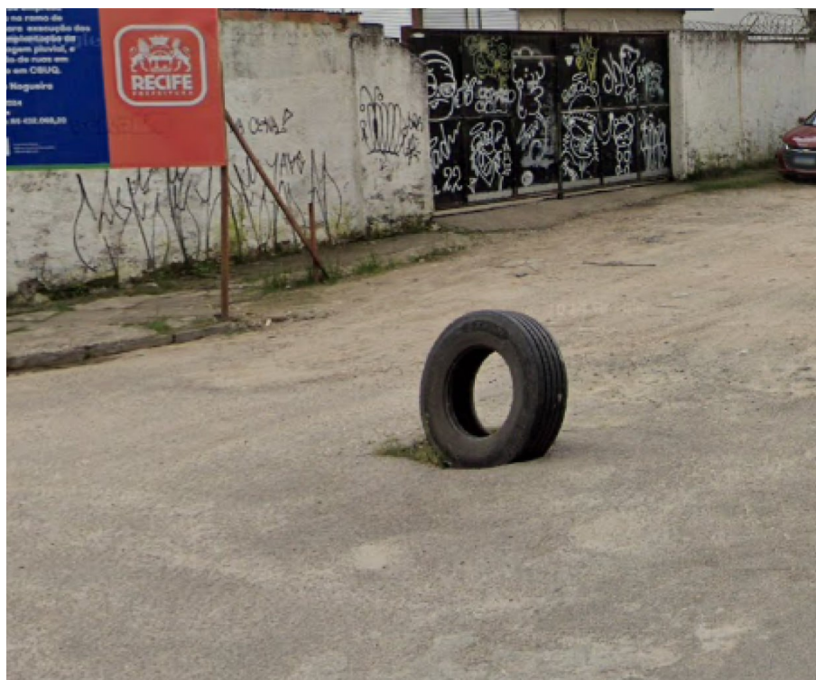
Figura 27: Gambiarra pneu sinalizando buraco
