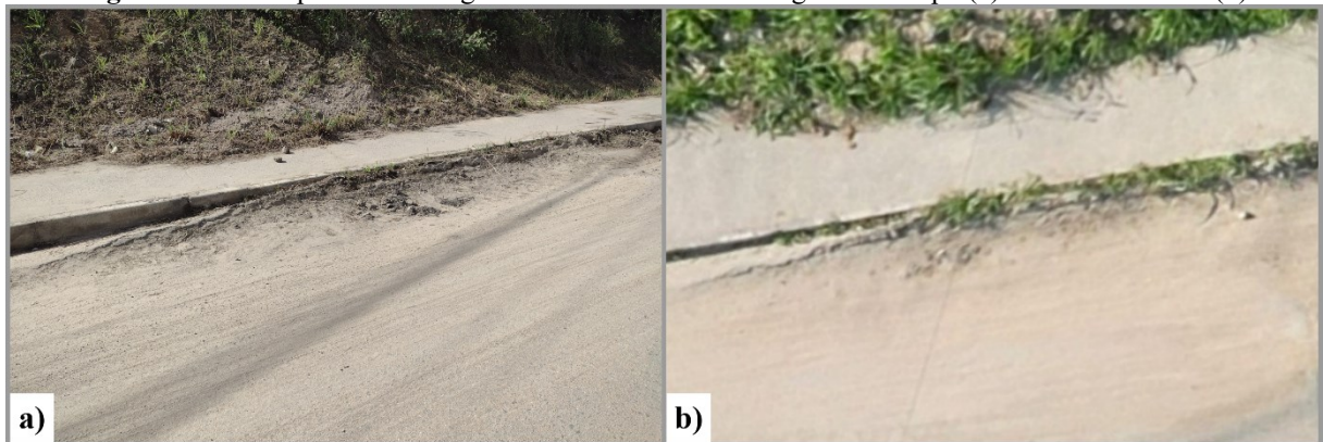
Figura 10 – Exemplo de escorregamento identificado na imagem de campo (a) e no ortomosaico (b)
