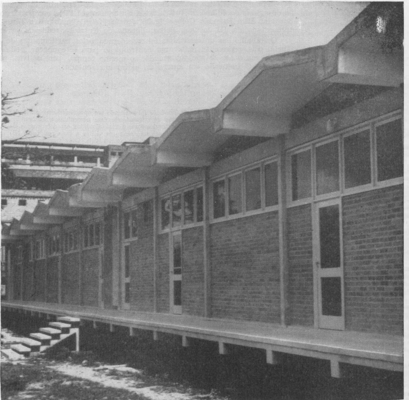
Dêse ângulo, vendo-se ao fundo o Hospital das Clínicas, em construção, aspecto de um dos galpões sobre pilotis, destinados às pesquisas, do novo Instituto de Micologia na Cidade Universitária
