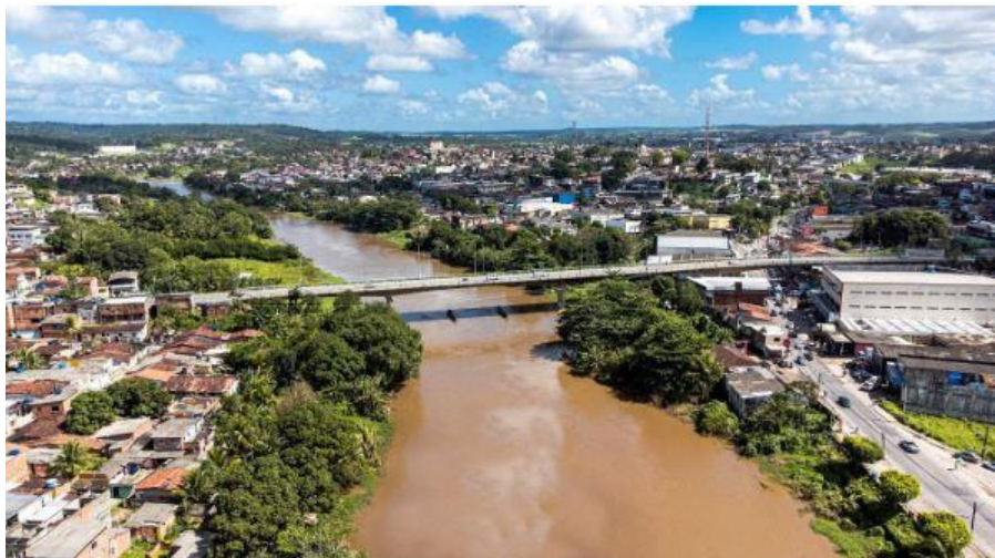
Figura 2 - Ponte sobre o Rio Capibaribe na cidade de São Lourenço da Mata
