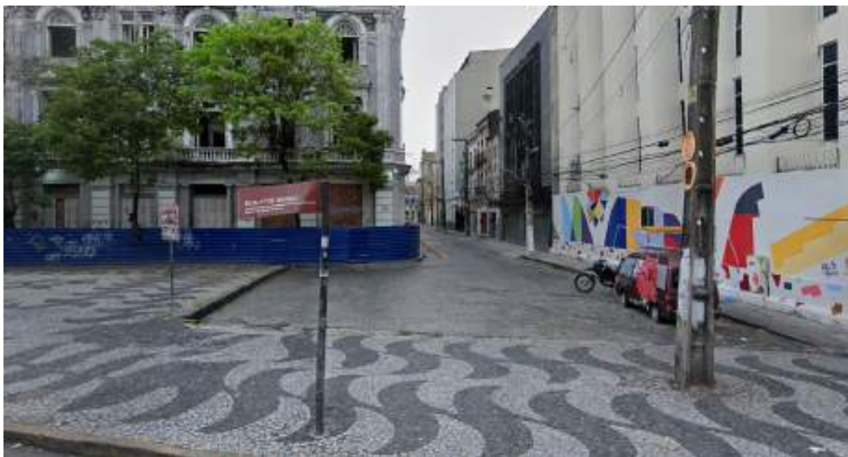
Figura 36 - Rua Diário de Pernambuco na lateral do edifício
