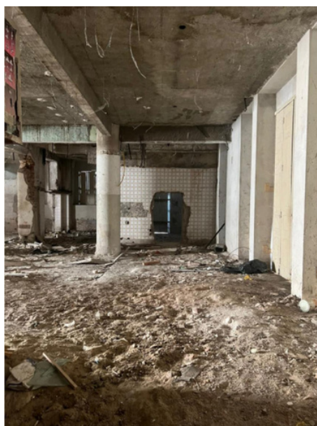
F.70, 71, 72 e 73 - Fotos da visita realizada antes das reformas pela CASACOR, ambientes onde será realizada a concretagem e o nivelamento de todo o piso térreo. Fonte: Gabriela Melo, 2022/ Sistema Eletrônico de Informações IPHAN.
