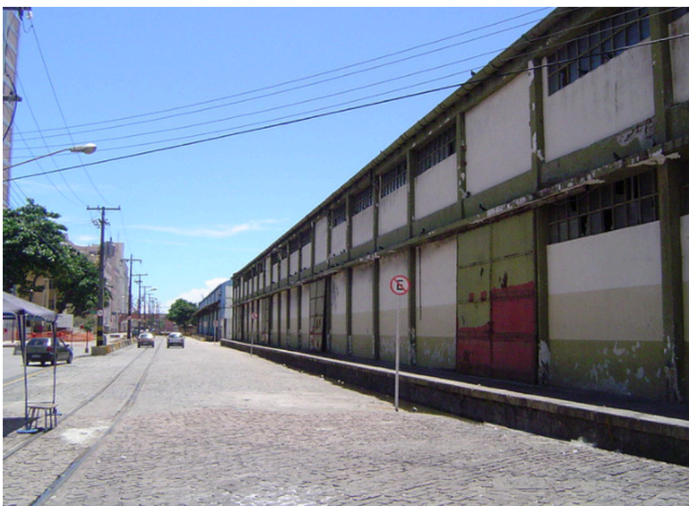
F. 106 - Registro do Armazém 11 antes de receber a mostra de eventos. Fonte: TC 2, 2006 - Flickr
