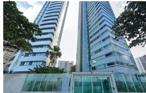
F.33 - Vista externa do imóvel ocupante do endereço do antigo casarão 4988. Fonte: Google Earth, 2024.
