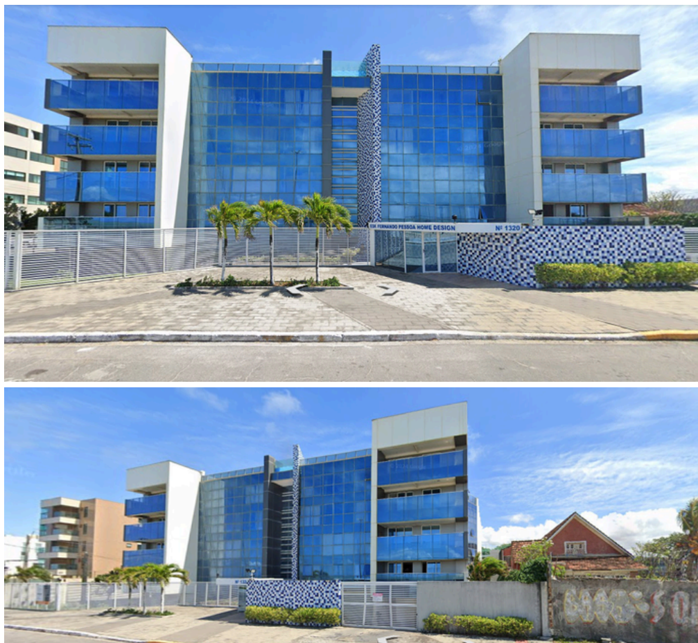
F.133 e 134 - Vista externa da edificação. Fonte: Google Street View, 2023.
