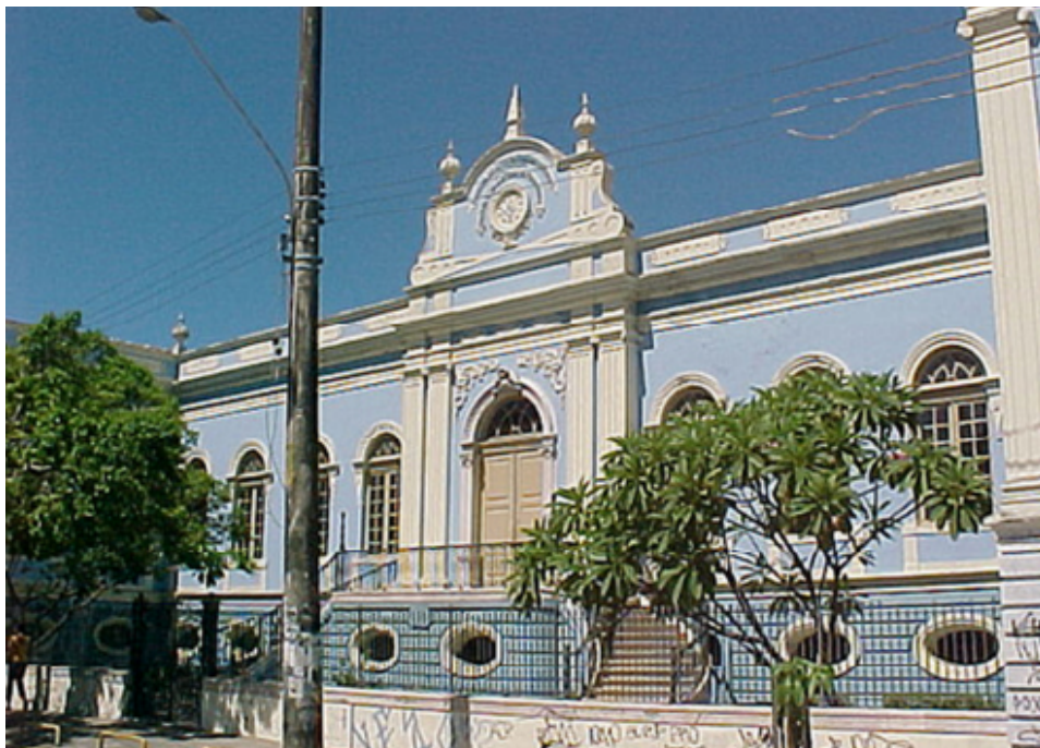
F. 99 - Situação da fachada em 2007 antes do CASACOR. Fonte: Acervo Jorge Passos, 2012.
