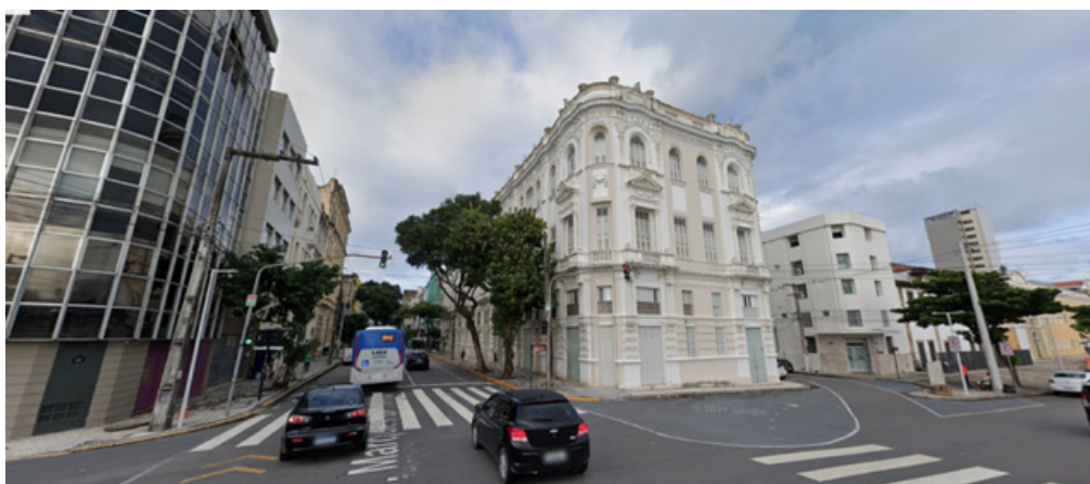
F. 162 - Fachada atual do Edifício Chanteclair. Fonte: Google Street Map, 2024.
