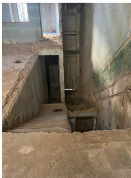
F.74, 75, 76 e 77 - Fotos da visita realizada antes das reformas pela CASACOR, ambientes onde será realizada o reparo e nivelamentos das paredes. Fonte: Gabriela Melo, 2022/ Sistema Eletrônico de Informações IPHAN.
