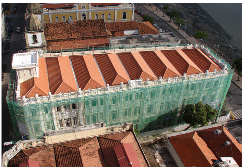
F.62 - Vista externa do edifício durante o processo de restauro das fachadas e cobertura. Fonte: Jorge Passos, 2012/ Jorge Passaos Arquitetura & Restauro.
