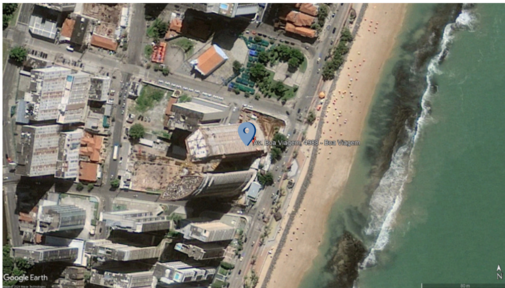
F.110 - Vista aérea do trecho em que estaria o casarão, foto de julho de 2009. Fonte: Google Earth Pro, 2024
