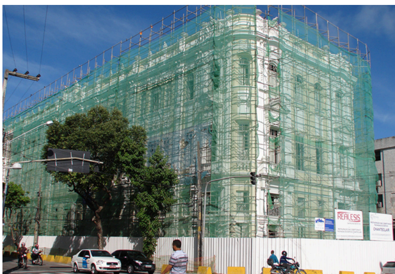
F.63 - Vista externa do edifício durante o processo de restauro das fachadas. Fonte: Jorge Passos, 2012/ Jorge Passaos Arquitetura & Restauro.
