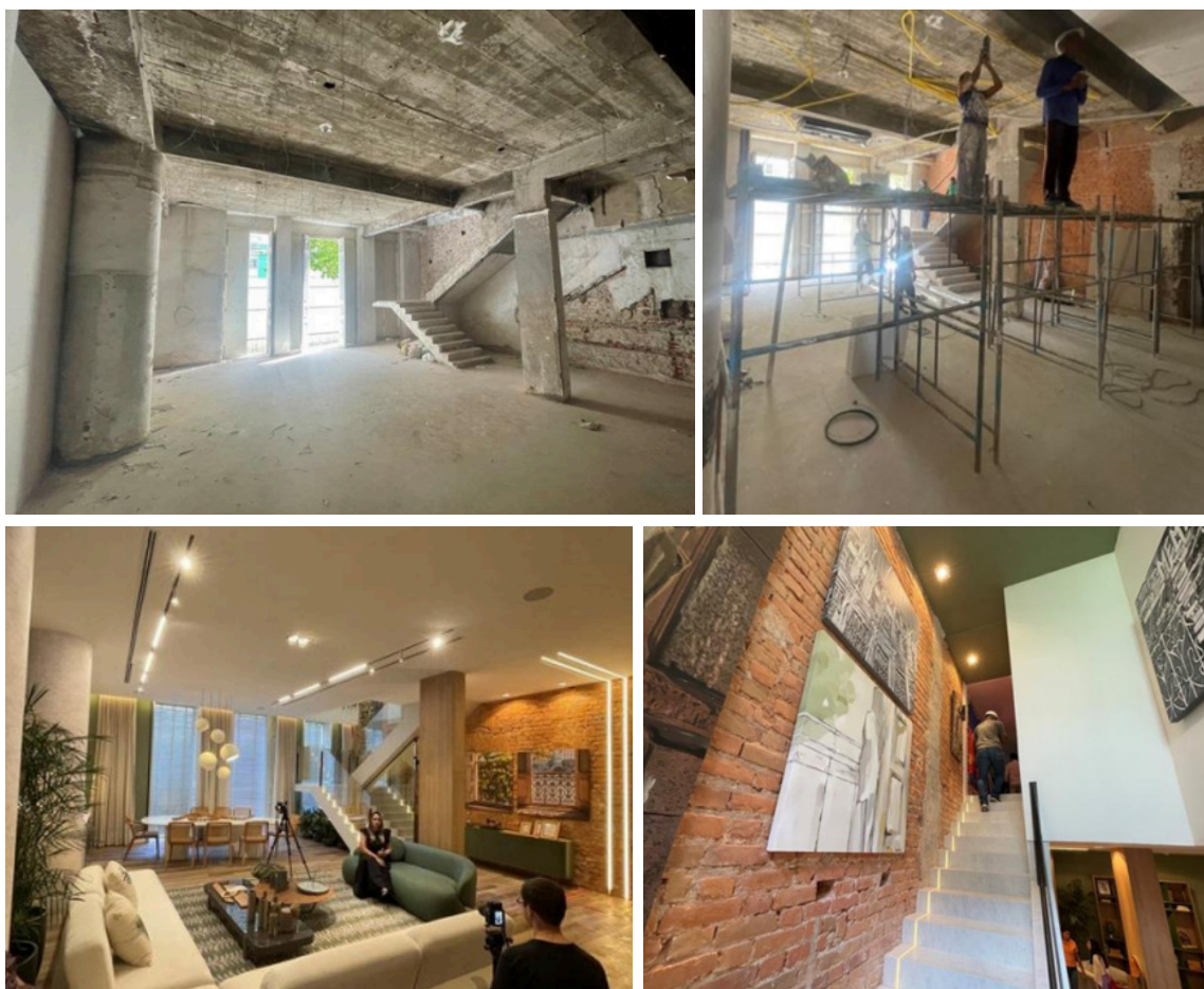
F. 87, 88, 89 e 90 - Fotos das visitas realizadas e antes das reformas, durante as reformas e no início do CASACOR, vista interna de alguns ambientes do térreo, entre julho e outubro. Fonte: João Magno Vieira de Mélo, 2022/ Sistema Eletrônico de Informações IPHAN.
