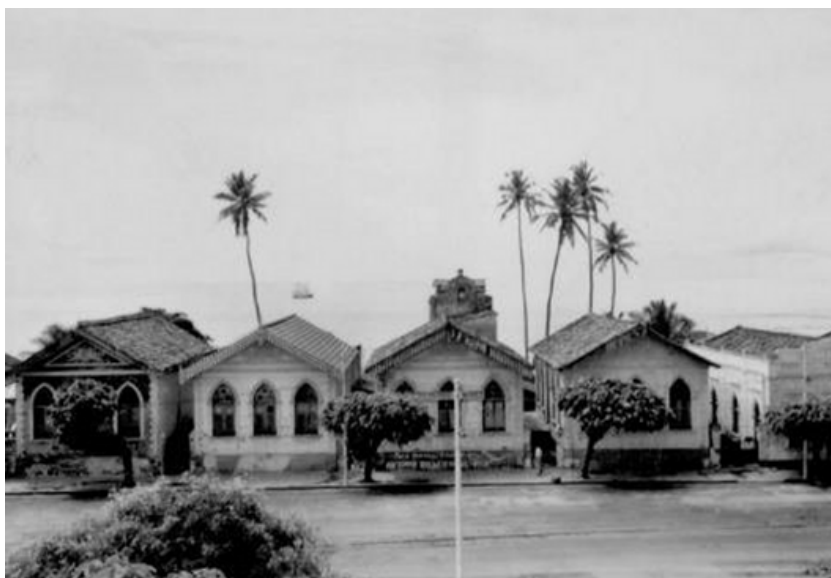
F. 114 - Vista geral do conjunto denunciando as perdas dos elementos decorativos da fachada frontal (lambrequins de madeira).
