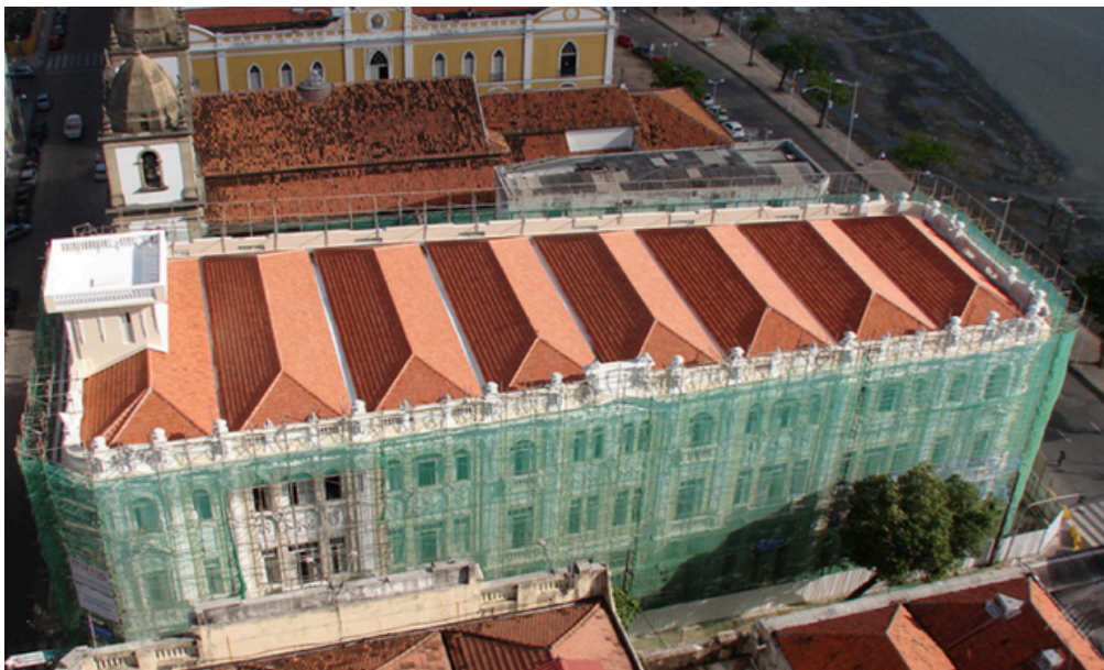
F. 158 - Foto da obra de recuperação da fachada do Edifício Chanteclair, por volta de 2012. Fonte: Acesso Jorge Passos.
