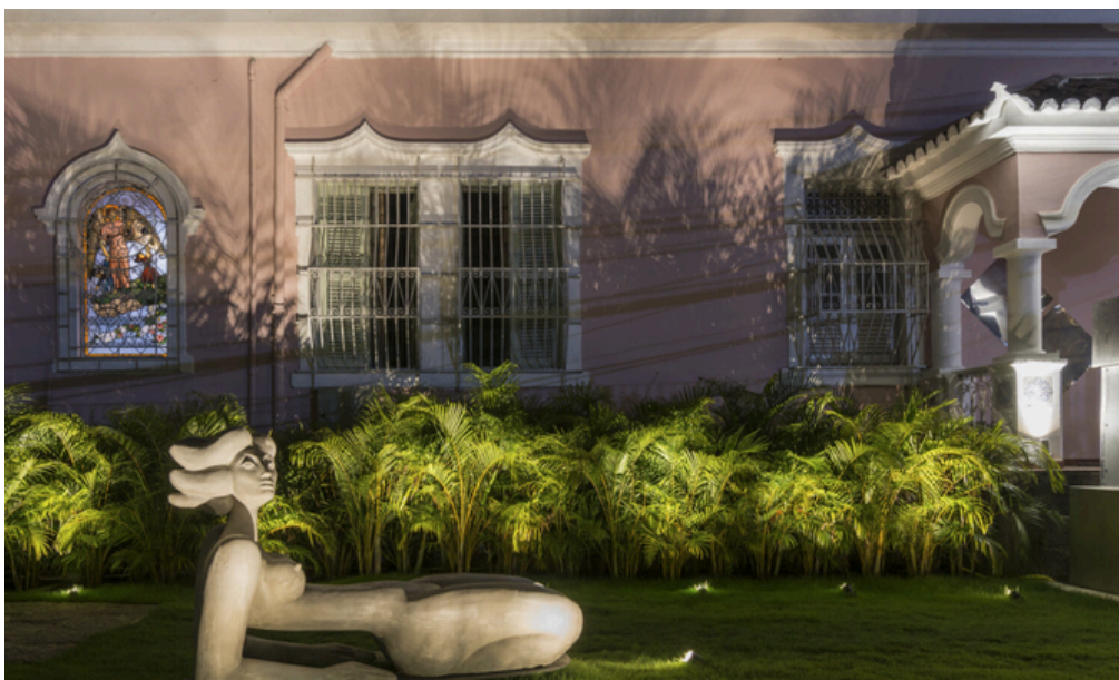
F.148 - Fachada lateral do casarão durante o CasaCor 2018. Fonte: Eduardo da Mata e Tadeu Melegatti -Lightsource, 2018.
