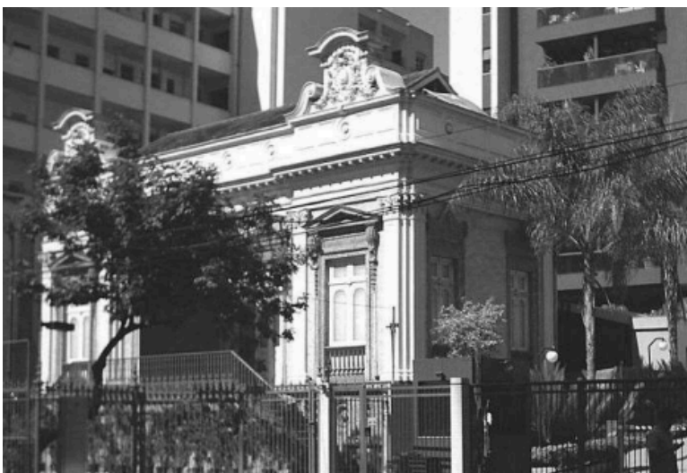
F.17 - Antigo Colégio Jacobina após restauro e adaptação, foto da época em que era o CAU RJ. Fonte: Seixas, 2009.
