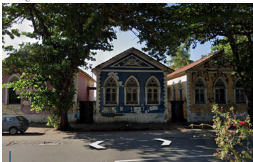
F.34 - Vista externa dos Chalés do Carmo. Fonte: Google Earth, 2024.
