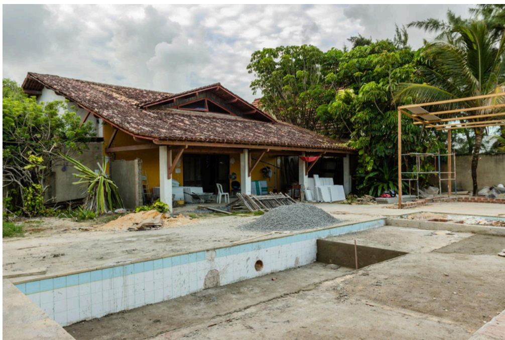
F.132 - Vista externa da edificação antes das obras para o evento. Fonte: Victor Muzzi/Revista SIM!, 2014.
