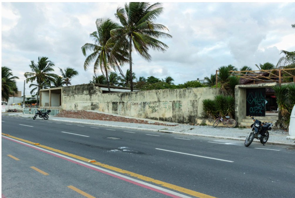
F. 131 - Vista externa da edificação antes das obras para o evento. Fonte: Victor Muzzi/Revista SIM!, 2014.
