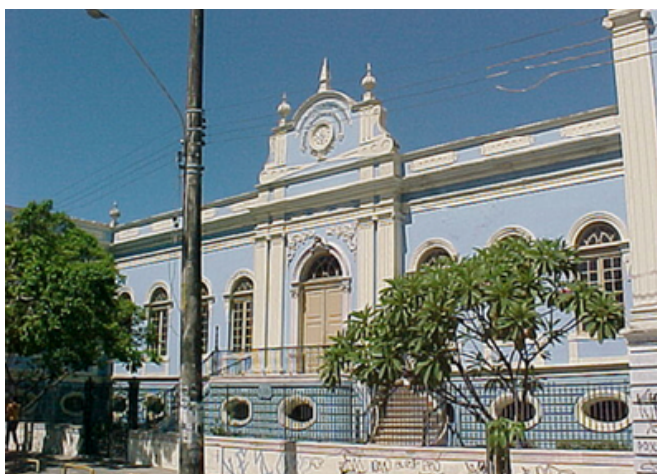
F.49 - Situação da fachada em 2007 antes do CASACOR 2008. Fonte: Acervo Jorge Passos, 2012.
