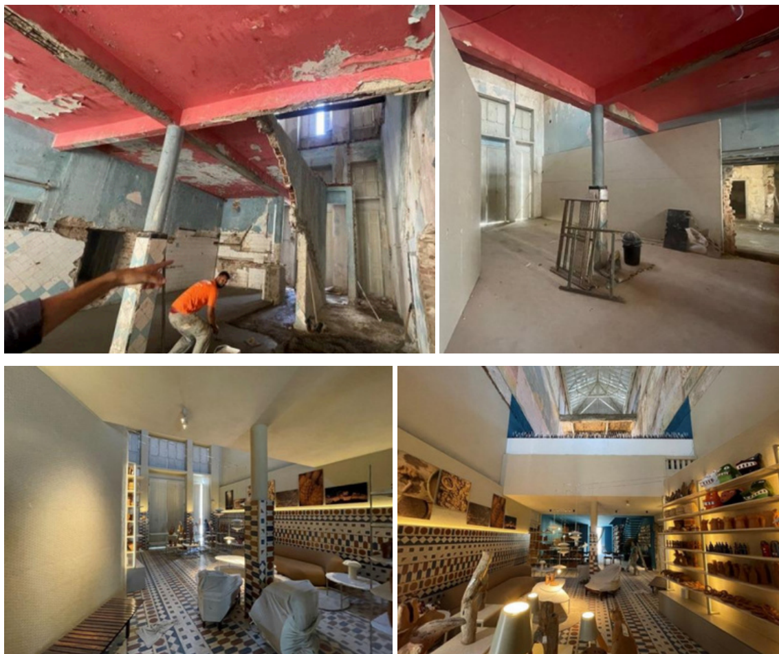
F. 83, 84, 85 e 86 - Fotos das visitas realizadas e antes das reformas, durante as reformas e no início do CASACOR vista interna de alguns ambientes do térreo, entre julho e outubro. Fonte: João Magno Vieira de Mélo, 2022/ Sistema Eletrônico de Informações IPHAN.
