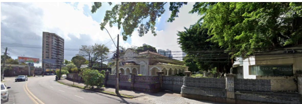
F.151 e 152 - Fachada do casarão em seu estado atual. Fonte: Google Street Map, 2024.
