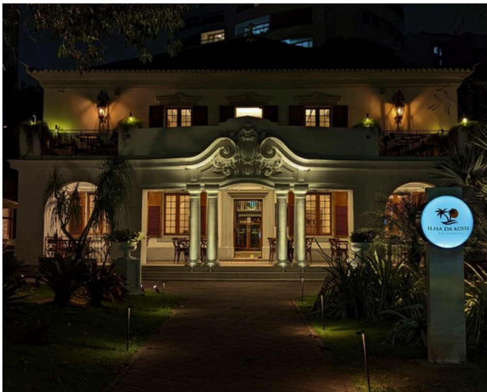
F.144 -Restaurante Ilha da Kosta, 2023. Fonte: Carminha Araújo/Google Maps.
