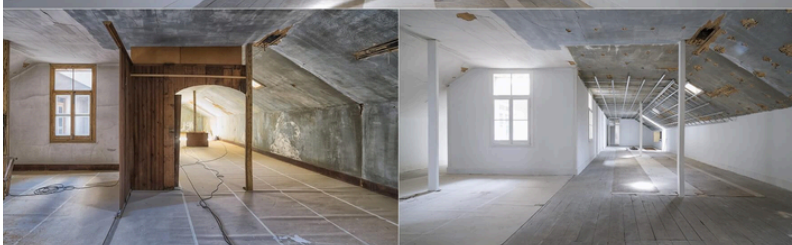
F.21,22, 23 - Processo de reforma no último piso do Palácio Sinel de Cordes. Fonte: Saint-Gobain Placo
