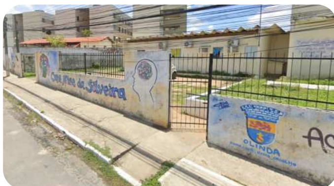
[Figura 12]: CAPS, Rua Trinta e Oito Fonte: Google Earth, 2022
