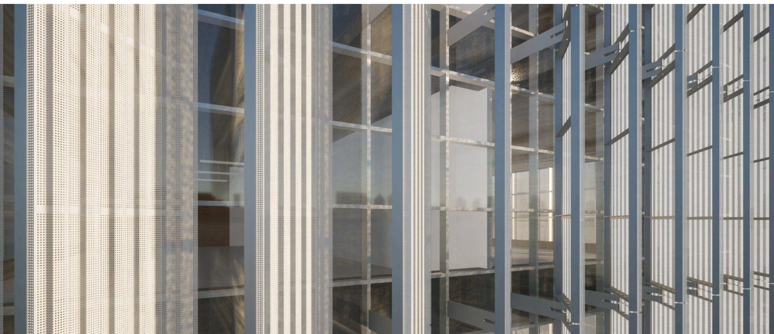
O detalhamento dos brises foram inspirados nos mesmos utilizados na sede do SEBRAE, chapas metálicas perfuradas e parafusadas em uma estrutura base que se prende ao edifício através de um apoio metálico central fixado diretamente nas lajes dos pavimentos. Também, foram aplicadas dobras verticais nas chapas metálicas para que a continuidade visual prevaleça sobre as marcações horizontais do travamento da estrutura base, além de permitir uma melhor cobertura contra a incidência solar nos vidros.
