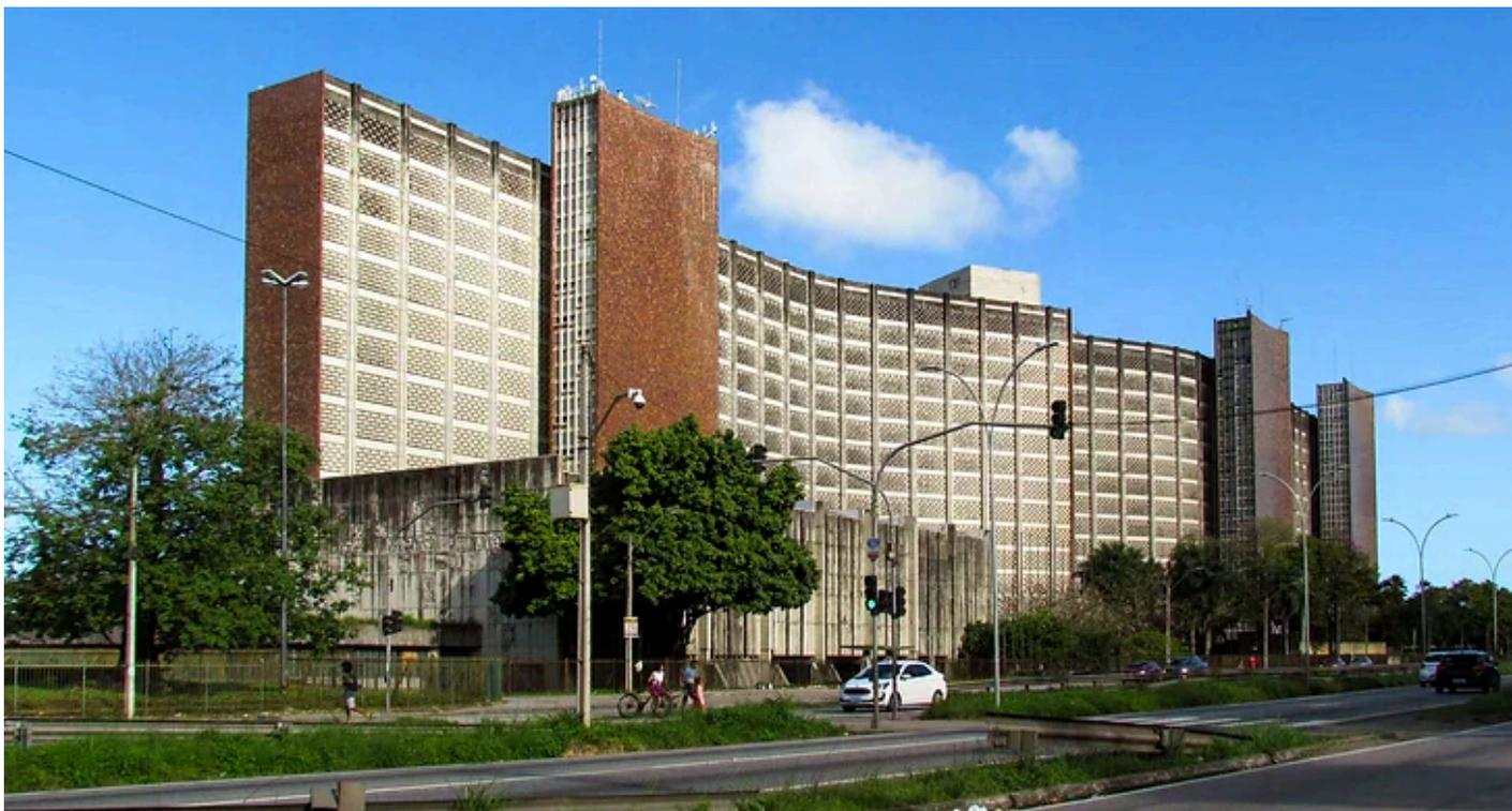
O edifício principal possui um extenso volume horizontal, a curta profundidade dos pavimentos retira a necessidade de divisão do espaço que impactaria negativamente a eficiência da ventilação cruzada projetada. No entanto, pelo grande comprimento da lâmina, o edifício apresenta mais de um núcleo, localizados fora do perímetro útil de locação e dispostos ao longo de sua extensão no lado poente.
