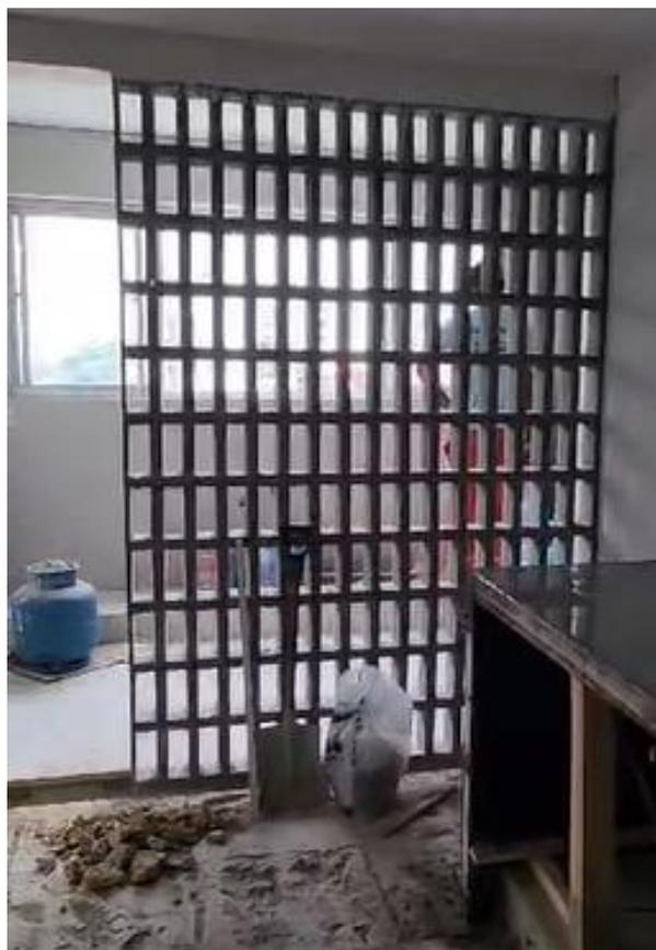
Figura 36- Parede com elementos vazados em obra.
