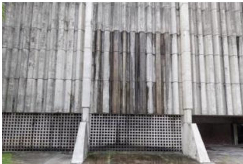
Figura 25- Fachada oeste do Auditório com marcação da fachada pelos pilares, com embasamento em contrafortes e fechamento em cobogós no subsolo.
