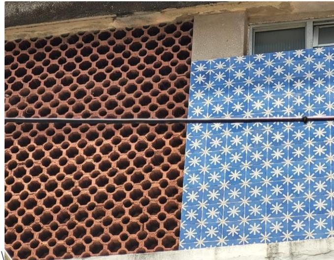
Figura 20- Edifício Santa Rita - Detalhe do elemento vazado
