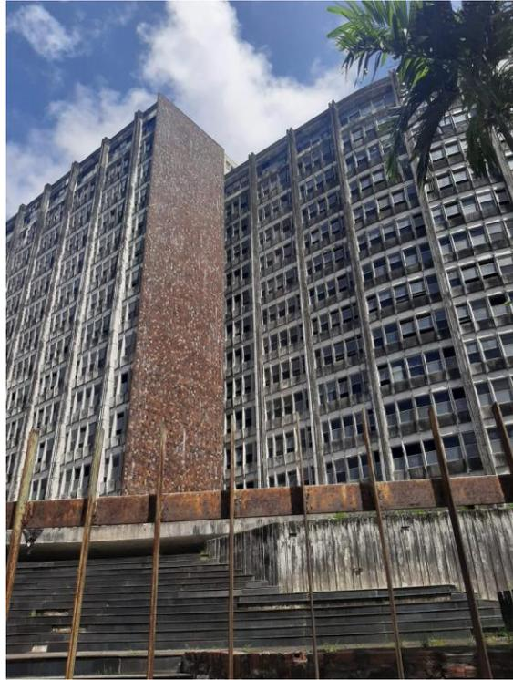
*Figura 23- Fachada com o acabamento com peitoril ventilado.*
