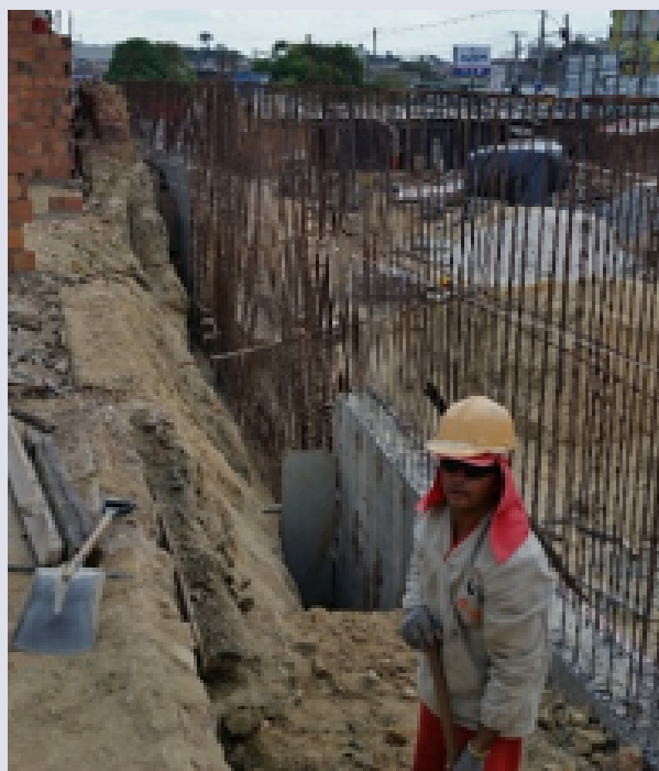
Operário realizando a reforma do prédio
