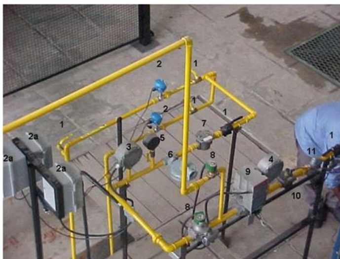
Figura 3.11 – Sistema utilizado na monitoração e controle das condições de combustão para o forno piloto.
