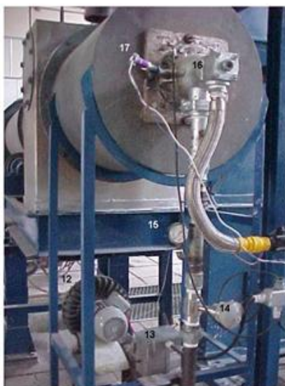
Figura 3.12 – Sistema de alimentação do ar de combustão e queimador.
