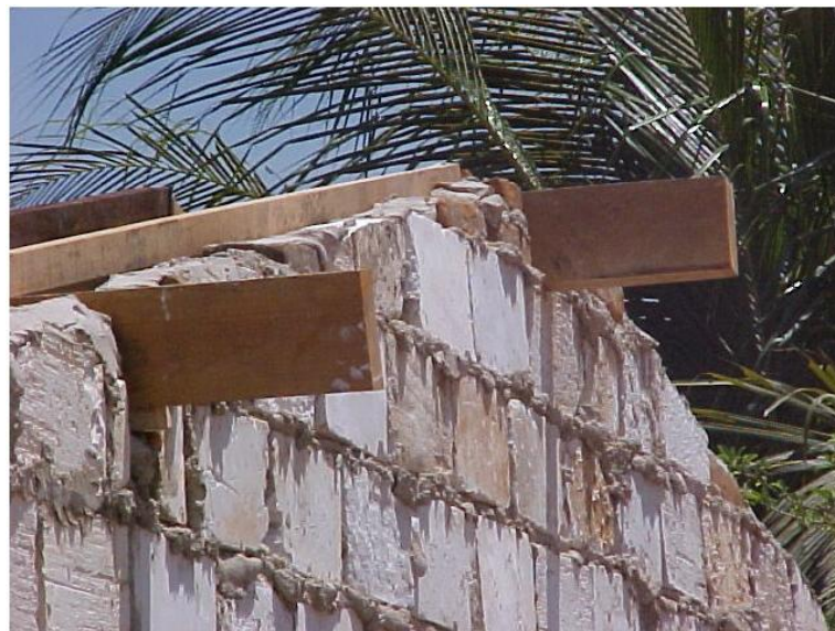
Figura 1.2 - Paredes construídas com blocos de material reciclado.
