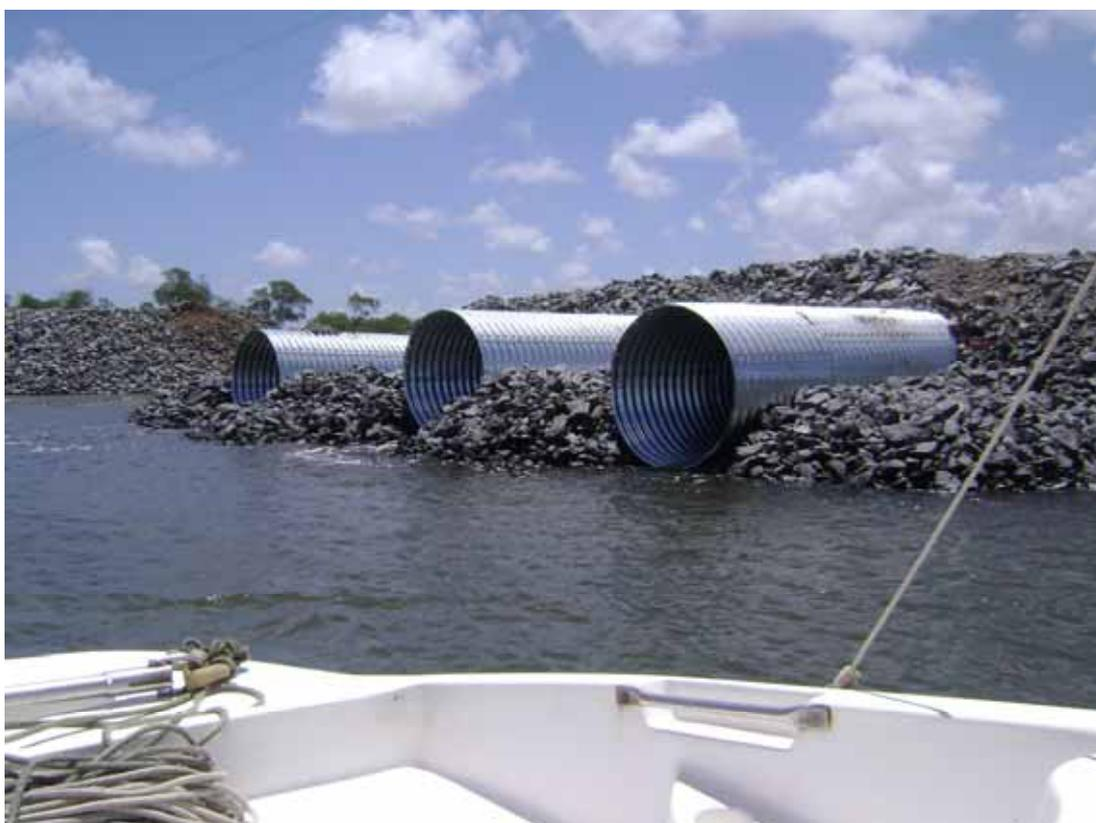
**Foto 12 – Vista geral do dique sendo construído na desembocadura do rio Tatuoca para dar acesso entre o Porto de Suape e a Ilha de Cocaia (Nov./2007).**
