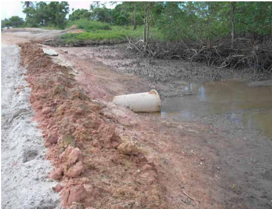
**Foto 13 – Vista parcial da estrada construída sobre o canal natural de acesso entre o rio Tatuoca e o Riacho Ilha da Cana, impedindo a circulação natural das águas (Jun./2006).**
