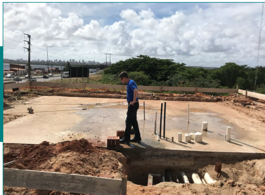
Imagem 16: Laje de Piso.
