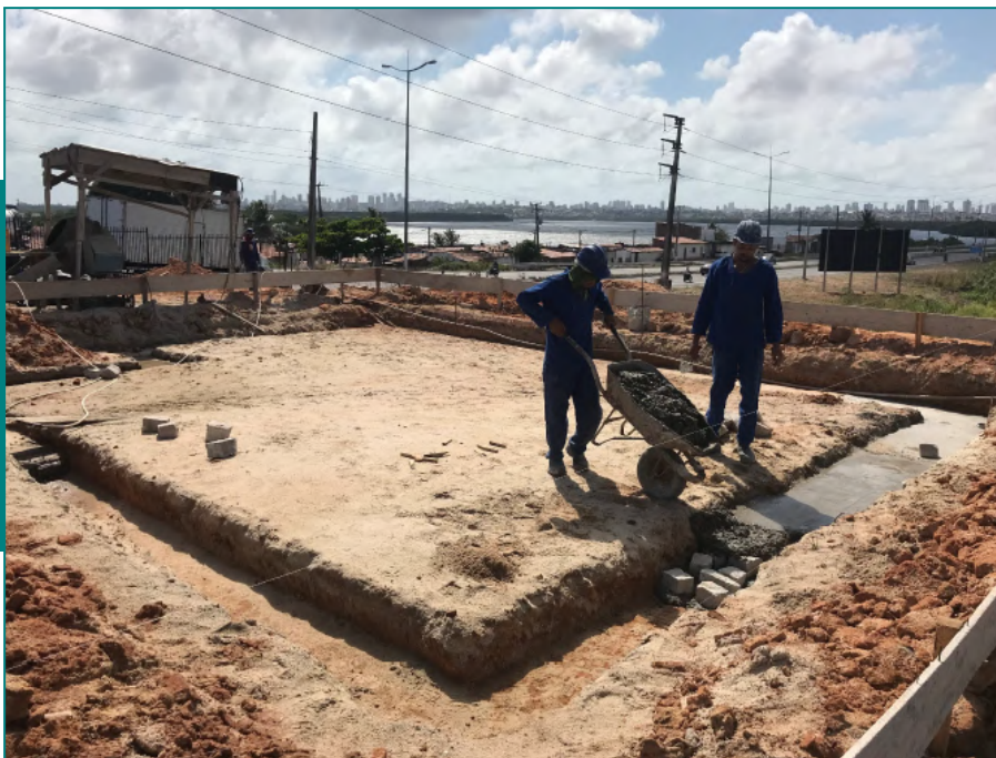
Imagem 15: Fundação da Obra.
