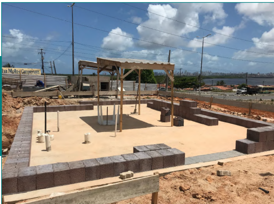
Imagem 17: Início da elevação da alvenaria estrutural.
