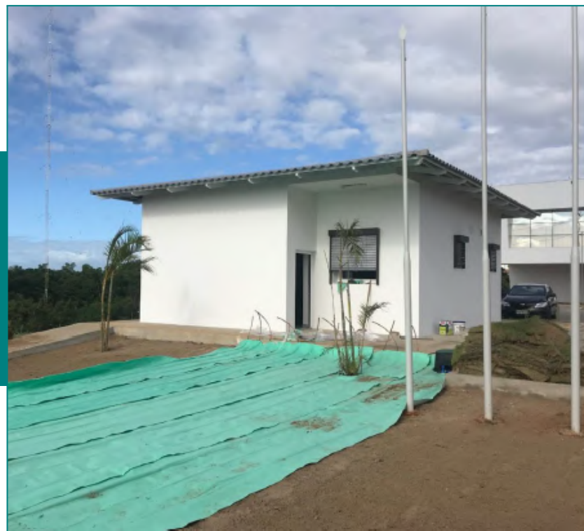
Imagem 20: Instalação do Sistema de Irrigação.
