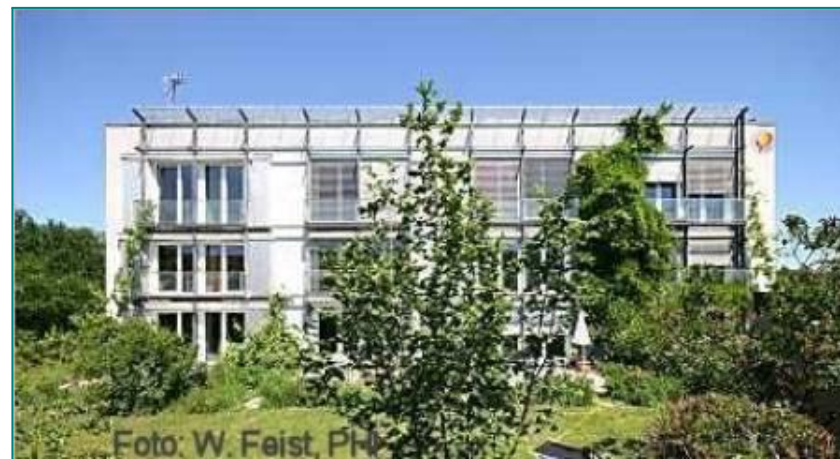
Imagem 7: Vista sul da Casa Passiva em Darmstadt-Kranichstein - fotografia: Wolfgang Feist. Fonte: https://passipedia.org/examples/residential_buildings/
