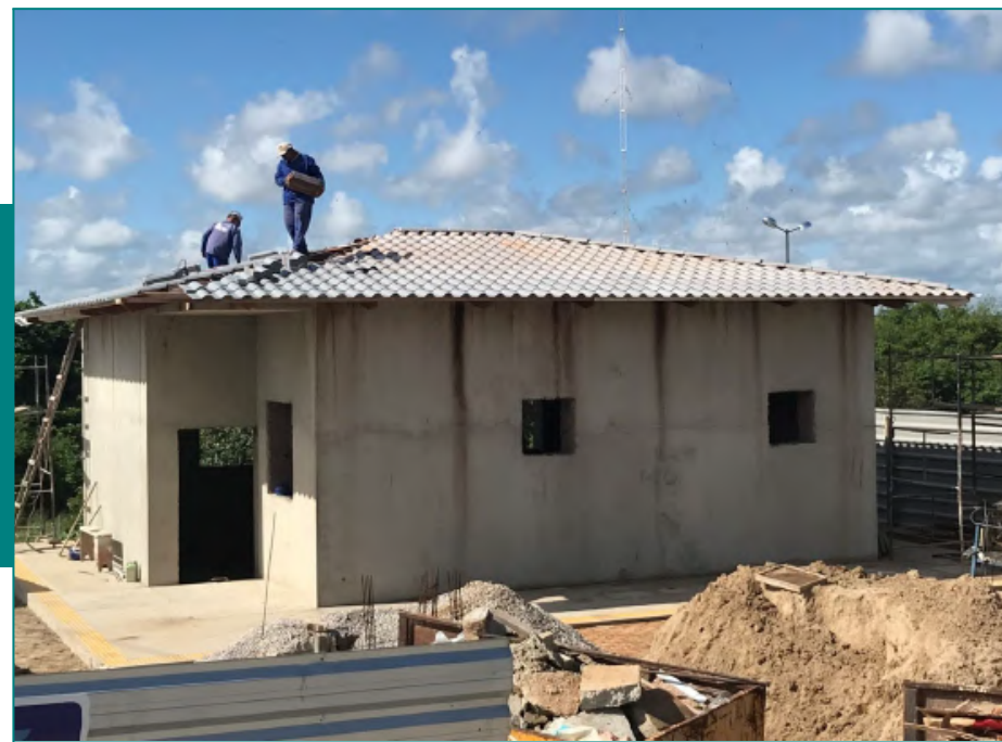
Imagem 18: Finalização da Coberta.
