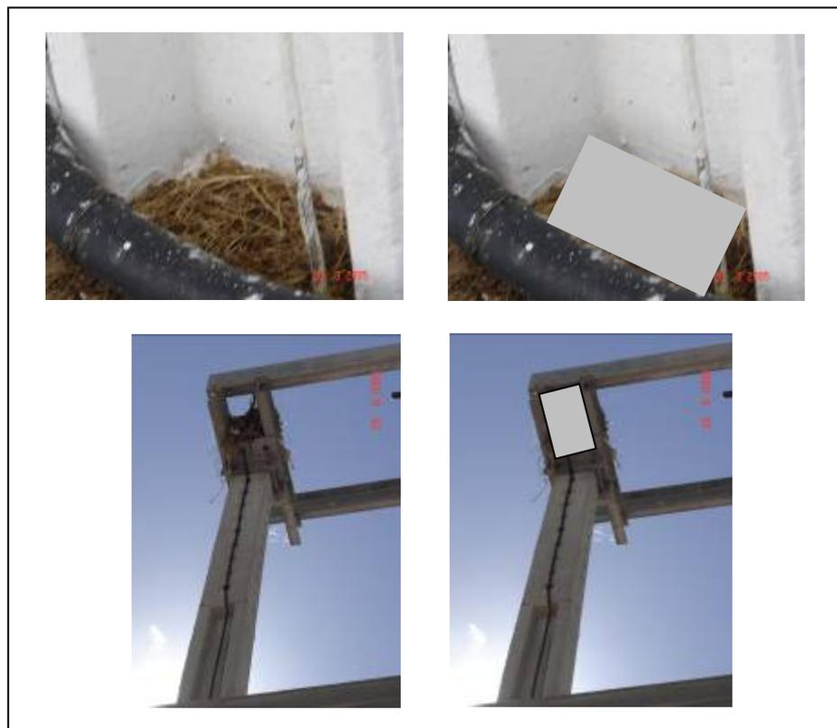
**Figura 8** - Vedação dos espaços existentes nas estruturas da SE
