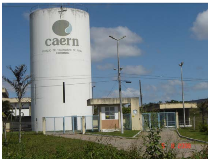
Figura 4.16 - Estação de tratamento de água, localizada nas proximidades da lagoa de Extremoz.
