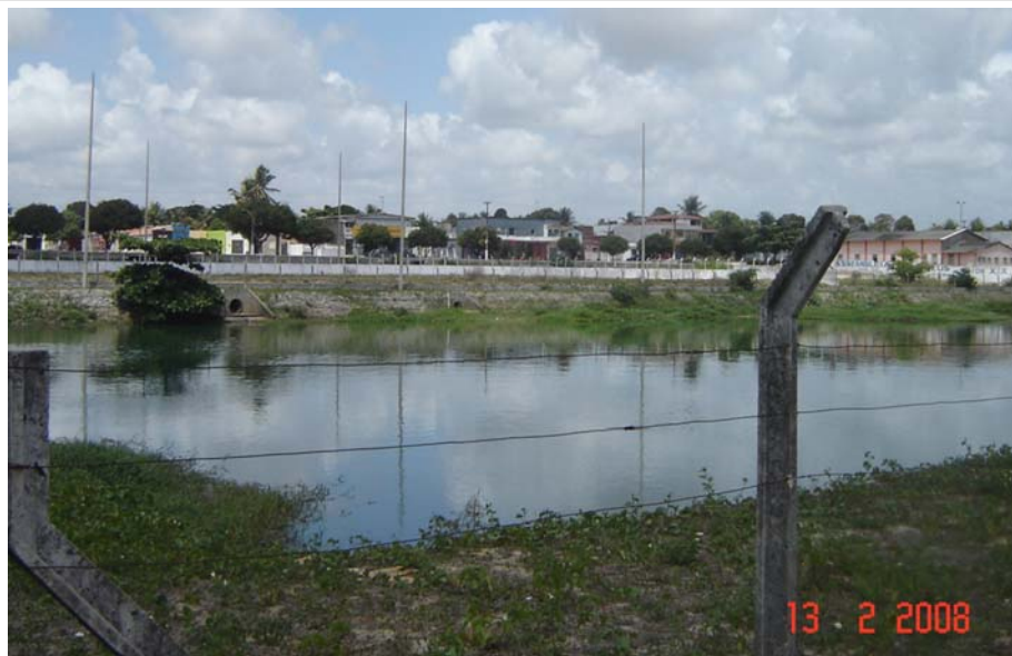
Figura 3.12 - Lagoa de infiltração de águas pluviais localizada no bairro Pajuçara apresentando carga líquida em um período de estiagem (13/02/2008).
