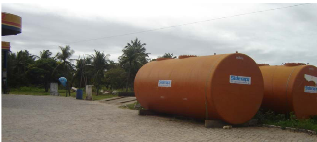
Figura 3.11 - Tanques subterrâneos para armazenamento de líquidos combustíveis, prontos para substituição, localizado nas proximidades da ponte do rio Doce na estrada da Redinha, bairro Pajuçara.
