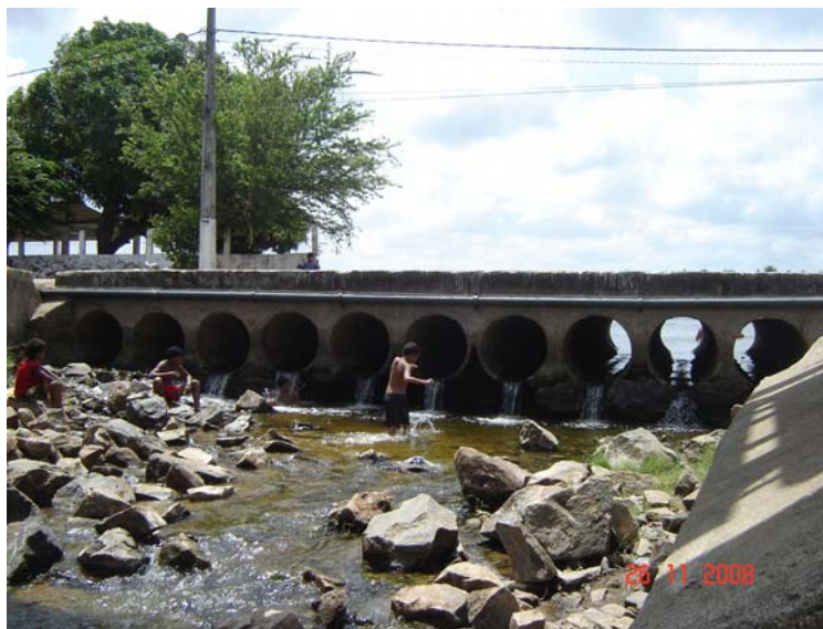
Figura 4.17 - Sangradouro da lagoa de Extremoz, que contribui com a vazão do rio Doce (novembro de 2008).
