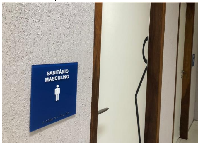
Figura 25 - Sinalização de sanitário masculino acessível do local
