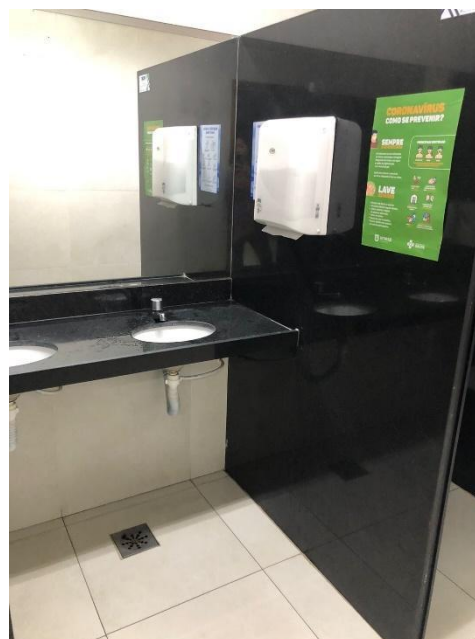
Figura 27 - Bancada do lavatório dos banheiros
