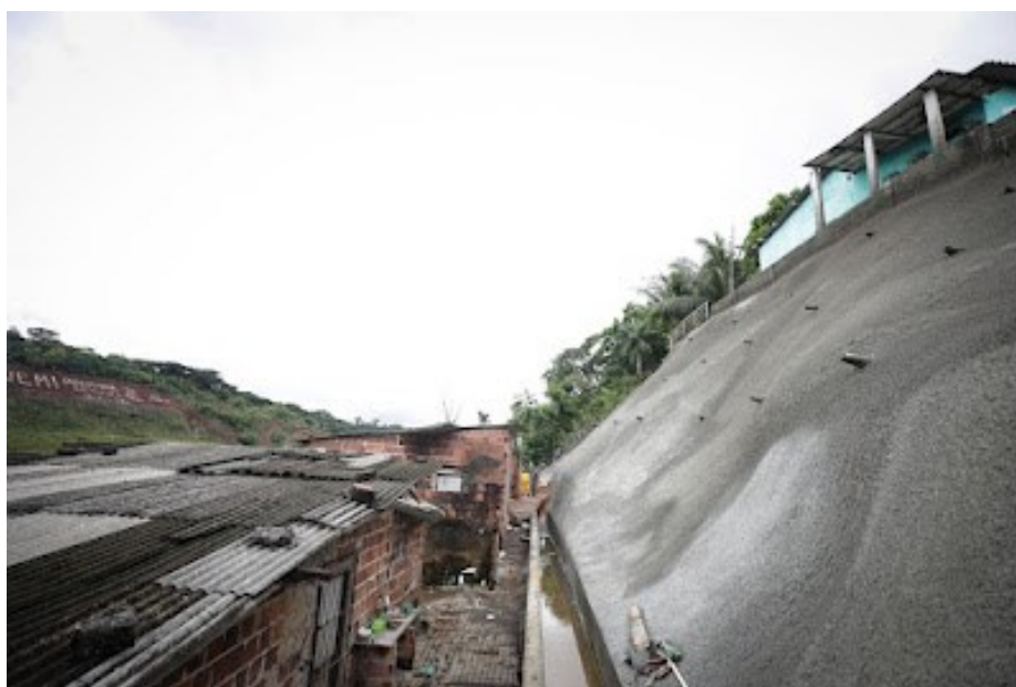
Figura 21 – Visão detalhada do solo grampeado no Córrego do Jenipapo
