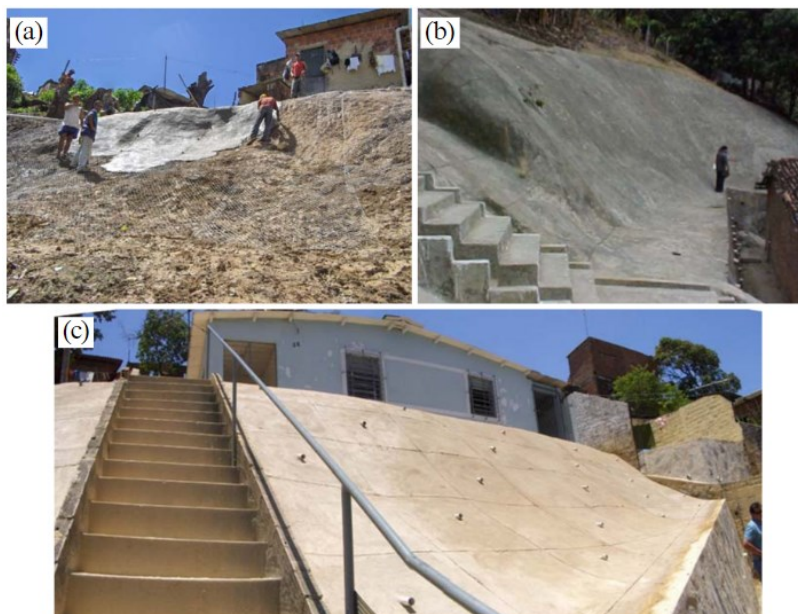
Figura 8 – Tela argamassada (a) em execução no município de Cabo de Santo Agostinho e já executadas nos municípios de (b) Camaragibe e (c) Recife
