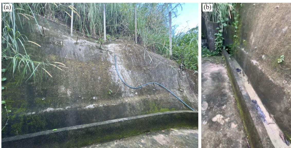
Figura 10 – Tela argamassada no bairro do Passarinho (a) em uma visão geral e (b) detalhe da canaleta
