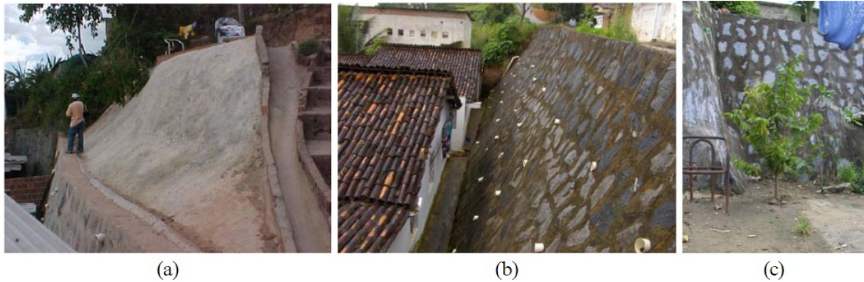
Figura 15 – Muro de concreto ciclópico em (a) São Lourenço, (b) Moreno e (c) Igarassu
